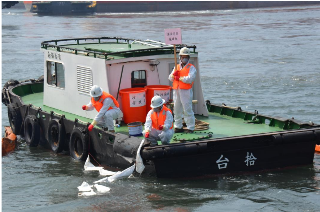
以吸油棉片吸取海上浮油 2
