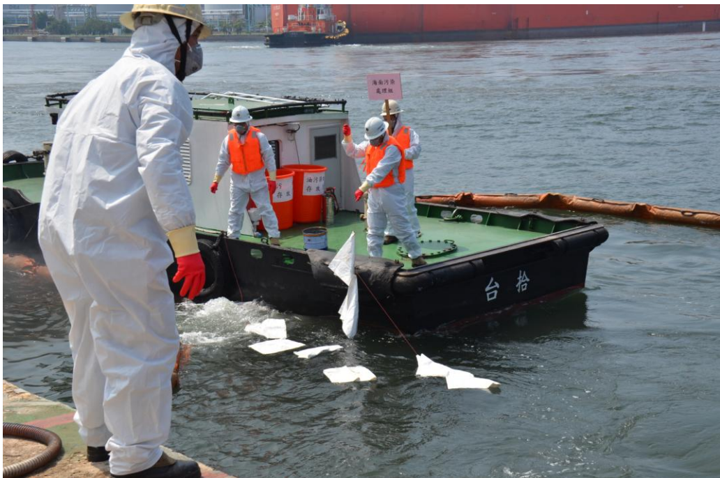
以吸油棉片吸取海上浮油 1
