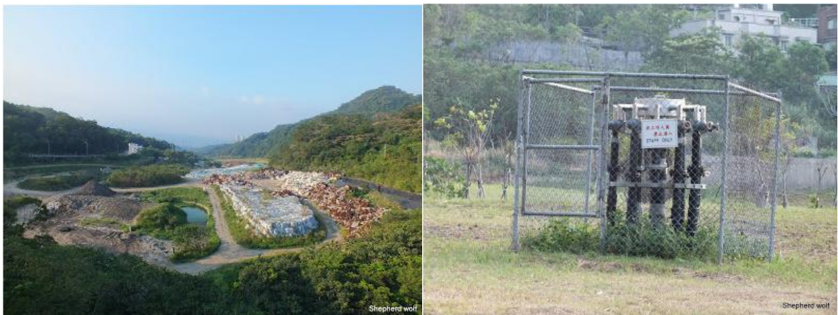
圖 7 山豬窟掩埋場空照及沼氣發電圖 [8]
