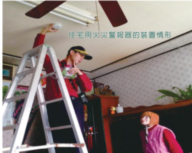
同樣地住警器可能因積塵結垢而影響其功能，導致無法於火災時發出警報聲響，也可能因電池沒電而無法作動，或因裝置年代久遠而故障損壞，因此安裝住警器後仍需要定期擦拭、保養測試及維護，甚至汰舊換新才能確保功能正常。
