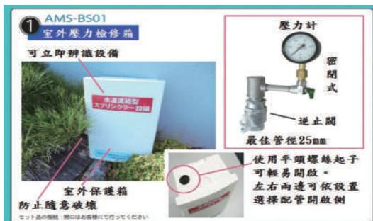
圖2. 構件1. 室外壓力檢修箱
