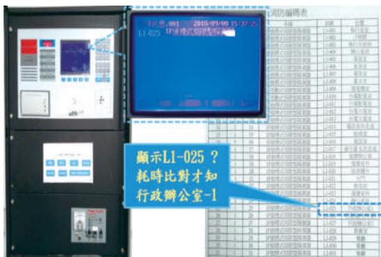
圖 3. R 型受信總機未明確顯示火警信號之空間
