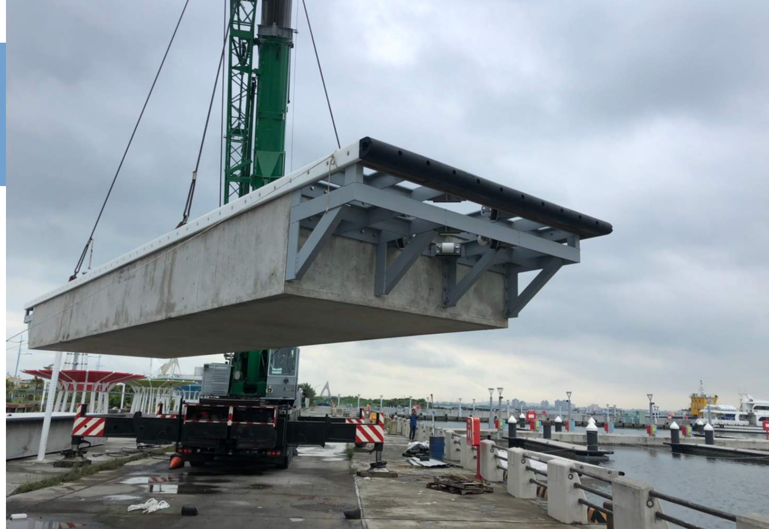
/ 浮箱體吊運照片
