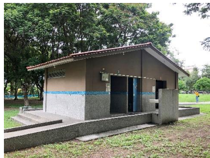
⑤ 既有公共廁所
