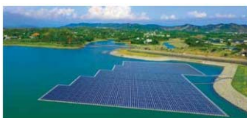
圖 15 阿公店水庫浮力式太陽能板
