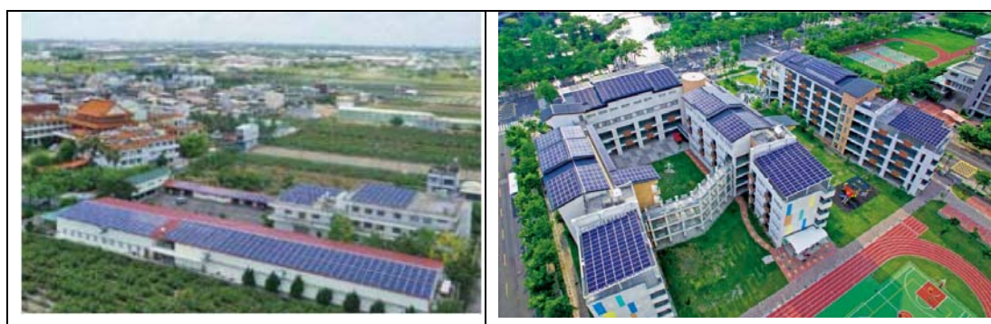
圖 16 國小屋頂設置太陽能板
