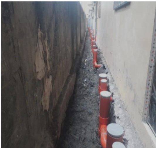
大寮區用戶接管施工
