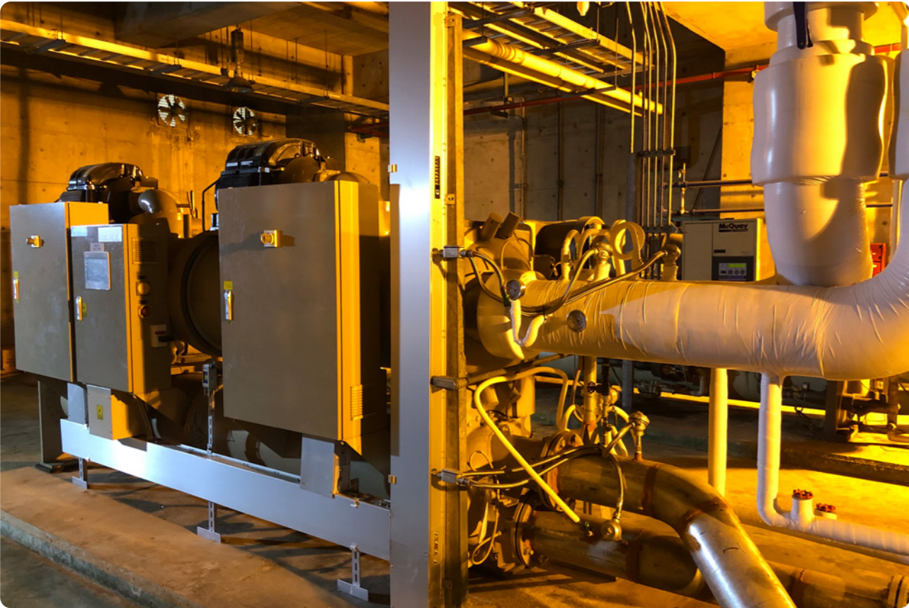
仁武資源回收廠冰水主機升級變頻控制系統
