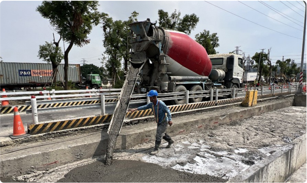
焚化再生粒料之控制性低強度回填材料 (CLSM) 澆置情形
