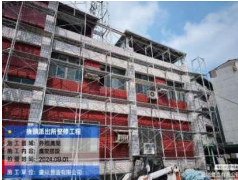
11 (施工中)橋頭所外牆防水施工中照片
