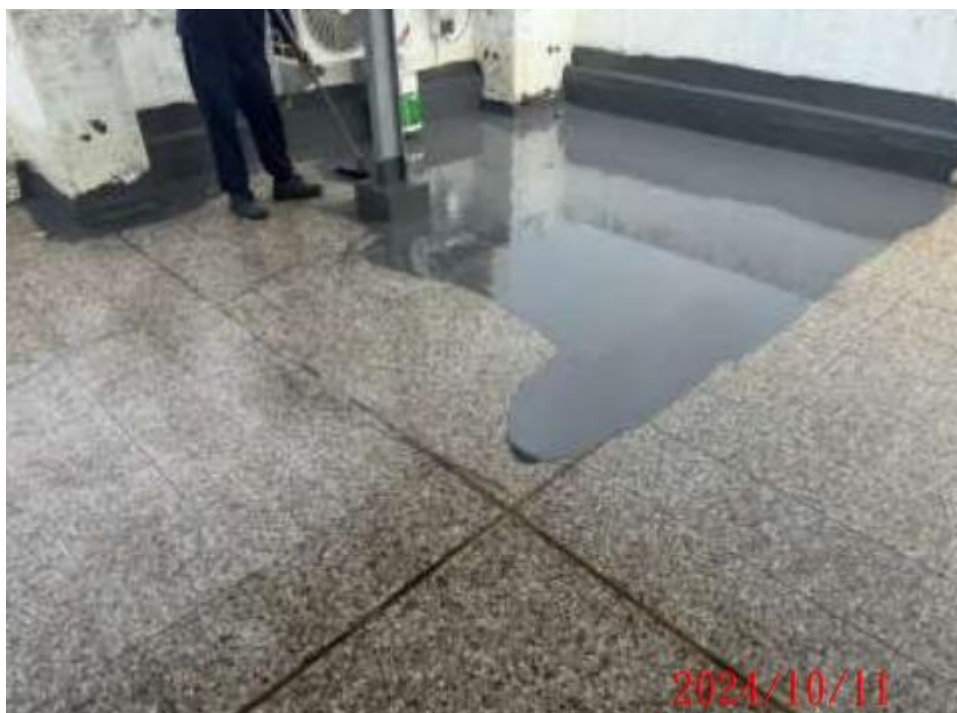
22（施工中）赤崁所3樓露臺施工照片
