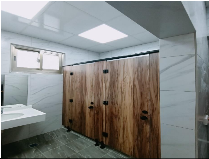
15 (施工後)橋頭所廁所施工完畢照片
