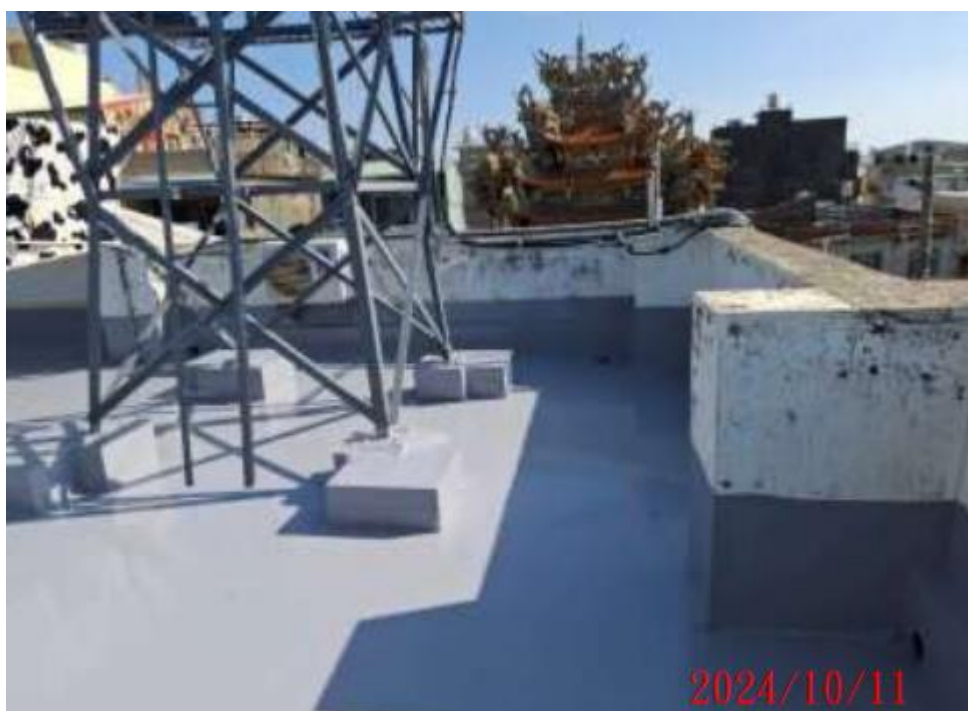
23（施工後）赤崁所3樓露臺施工完畢照片
