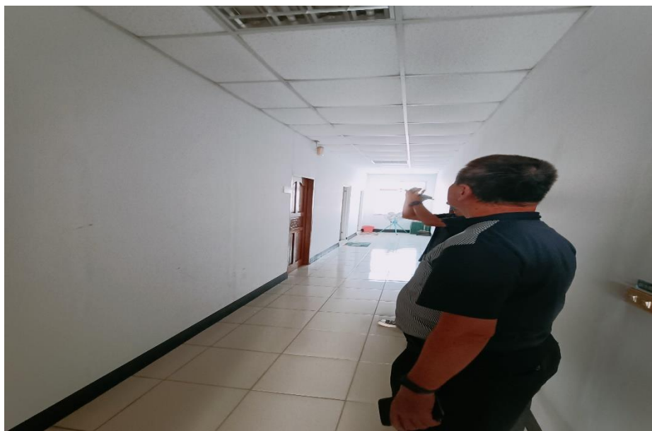
25（施工後）赤崁所待勤室大門上方漏水施工完畢照片
