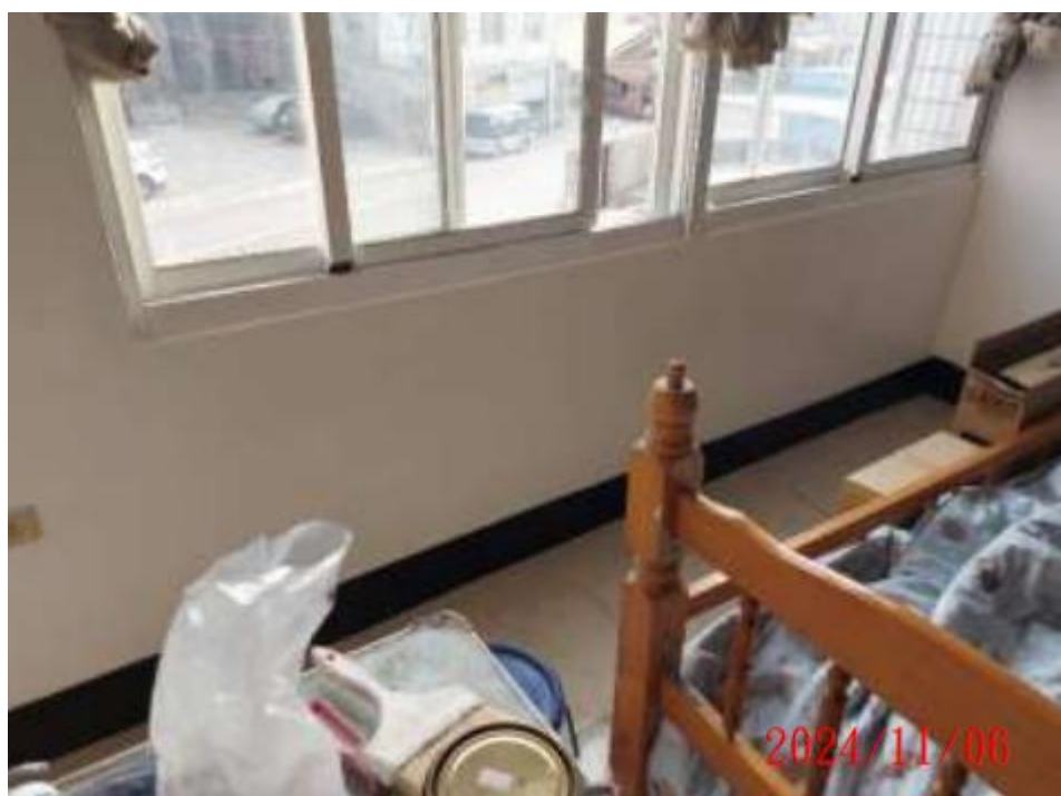
24（施工後）赤崁所2樓待勤室施工完畢照片
