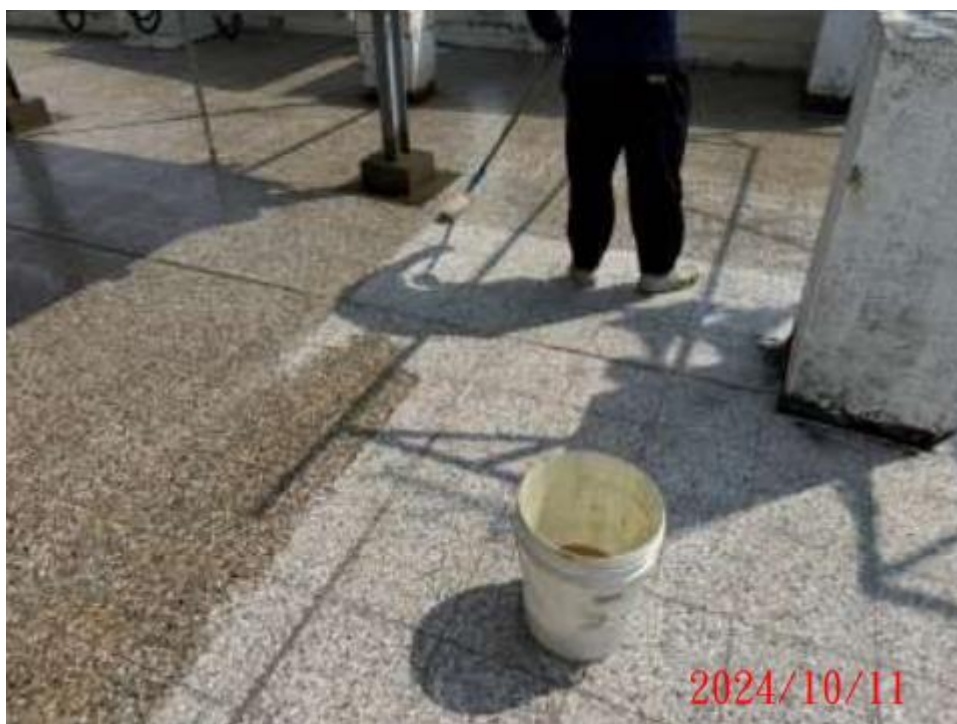
21（施工中）赤崁所3樓露臺施工照片
