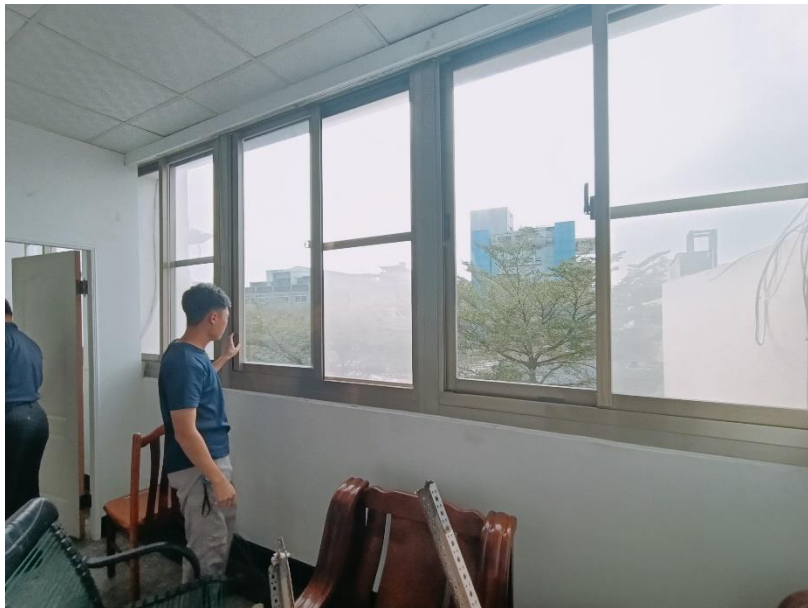
14 (施工後)橋頭所窗框漏水施工完畢照片
