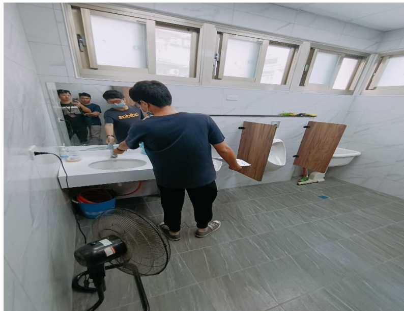
16 (施工後)橋頭所廁所施工完畢照片
