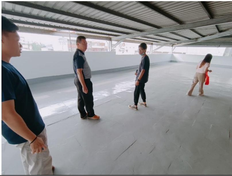
13 (施工後)橋頭所3樓露臺室施工完畢照片
