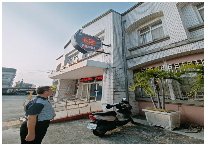
26（施工後）赤崁所3樓露臺增設排水明管施工完畢照片
