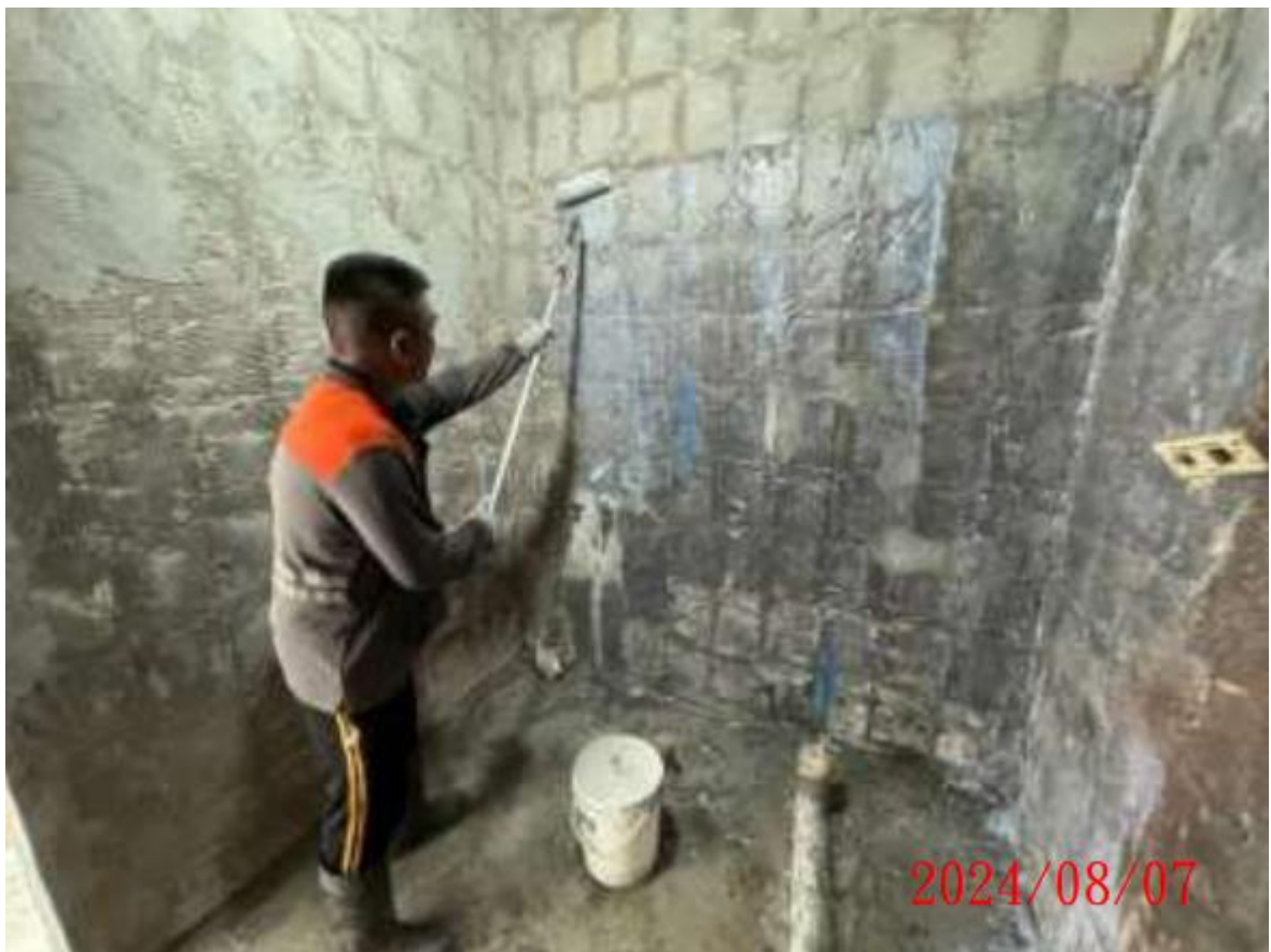
8 (施工中)橋頭所廁所全部打除照片
