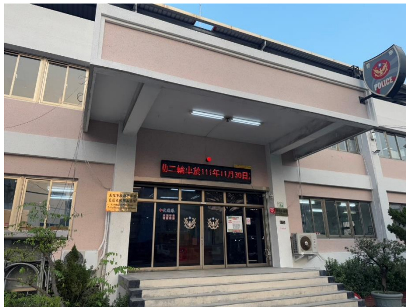
12 (施工後)橋頭所外牆防水施工完畢照片
