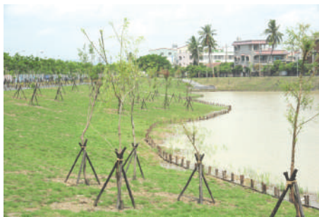
典寶溪 A 區滯洪池
