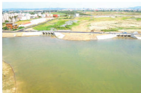
典寶溪 A 區滯洪池
