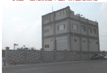
旗山區市區五號排水溝抽水站
