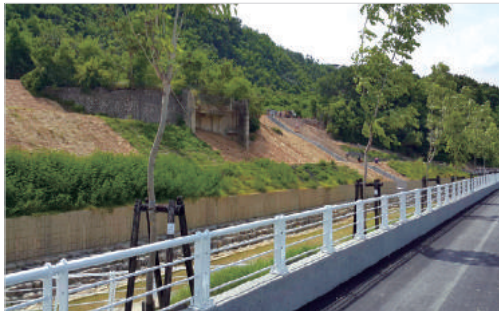
鼓山區台泥滯洪池上方裸露坡面敷蓋及坡面排水改善工程
