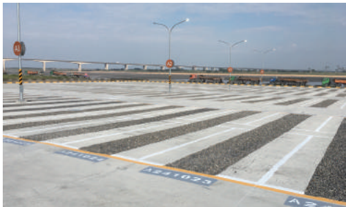
統嶺社區南側公有停車場
