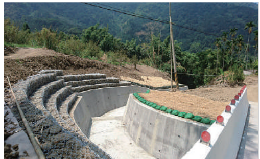
青山段福德祠下方野溪整治工程
