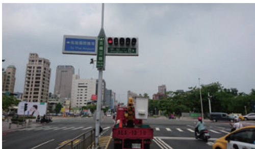
中山 / 五福路口管線下地
