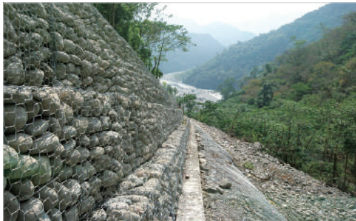
萬山部落下方崩場地處理工程
