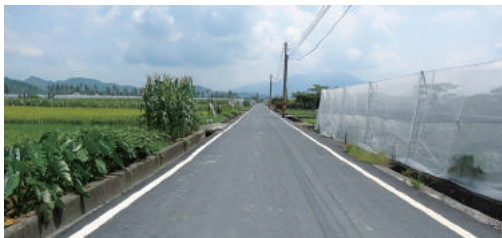
農地重劃區急要農水路改善工程
