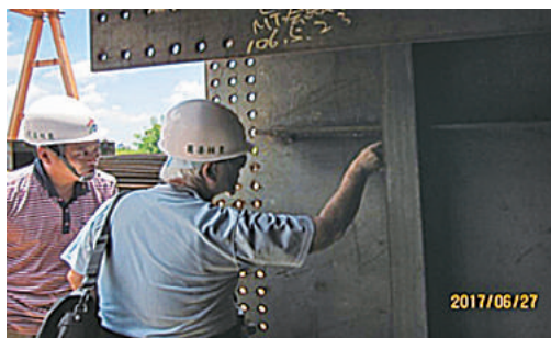
赴鋼構廠查驗鋼構材料之品質
