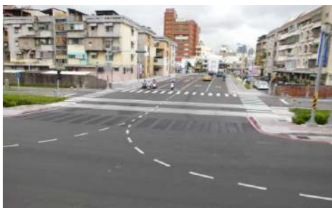
鼓山大公路陸橋拆除暨平面道路打通工程
