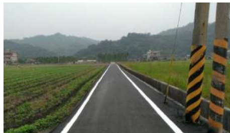
102 年度農地重劃區急要農水路改善工程
