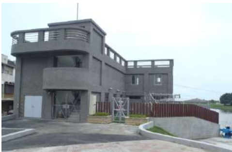
楠梓區右昌街與美昌街 165 巷抽水站-2
