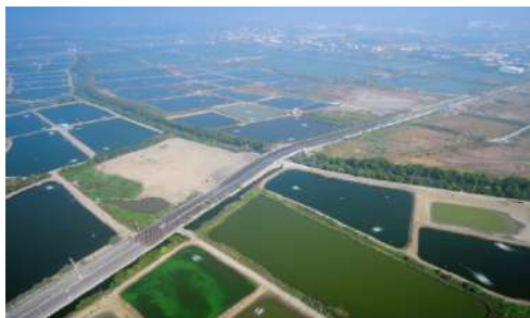
永安橋改建工程
