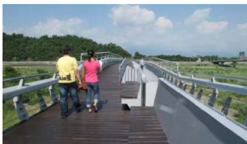
旗山地景橋改善工程-2
