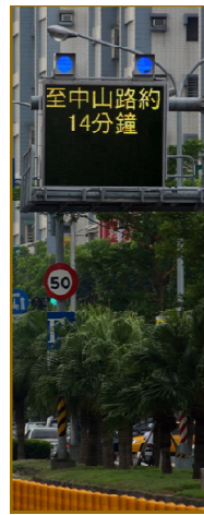
資訊可變標誌 (CMS)
