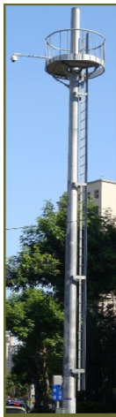
路況監視 系統 (CCTV)
