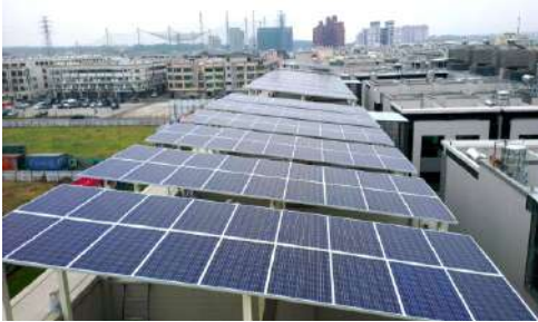
高雄市建築物屋頂設置太陽光電設施
