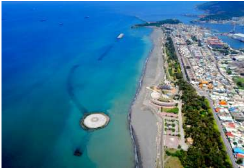
旗津海岸潛堤工程
