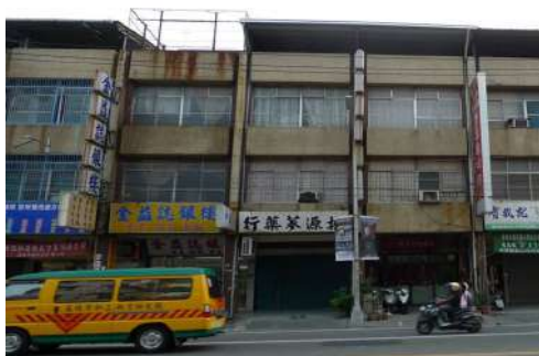
鳳山區光遠路修繕前
