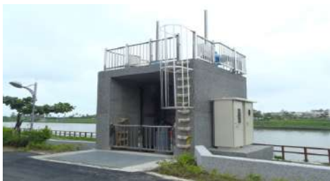
楠梓區右昌街與美昌街 165 巷抽水站-1
