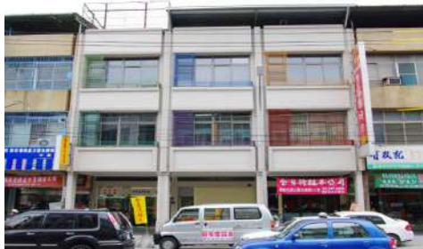
鳳山區光遠路修繕後
