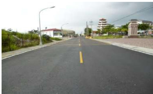
橋頭高 36-2 線甲樹路(里林東路-高 30 線)道路拓寬工程
