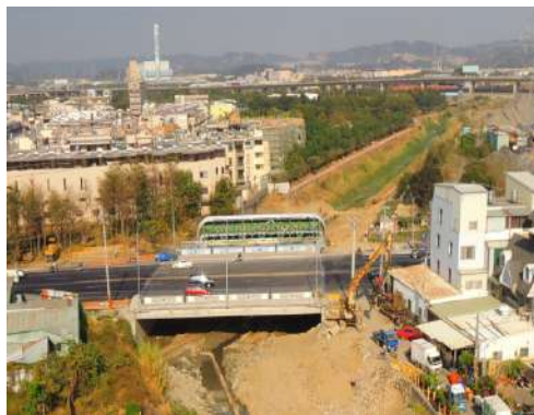
仁武區縣道中欄橋拓寬改建工程
