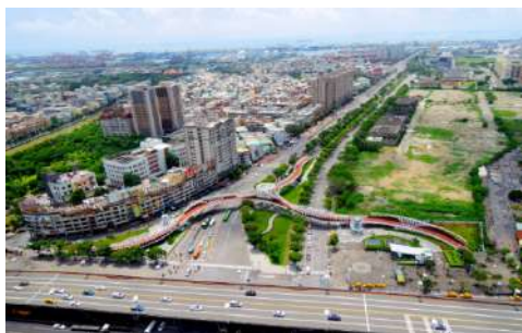
前鎮區中山四路與凱旋自行車橋工程
