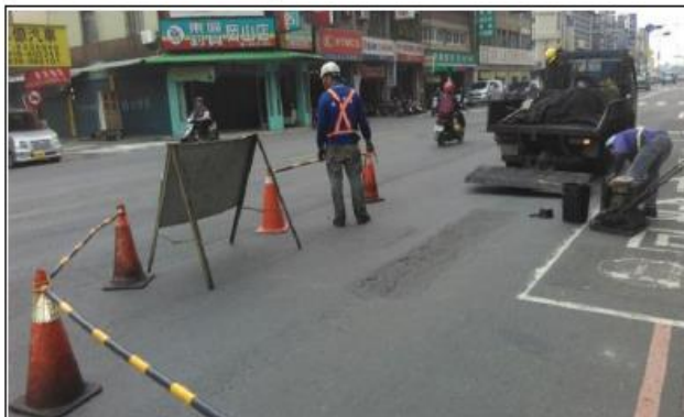
路面龜裂改善範例
