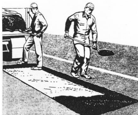
鋪設瀝青混凝土
