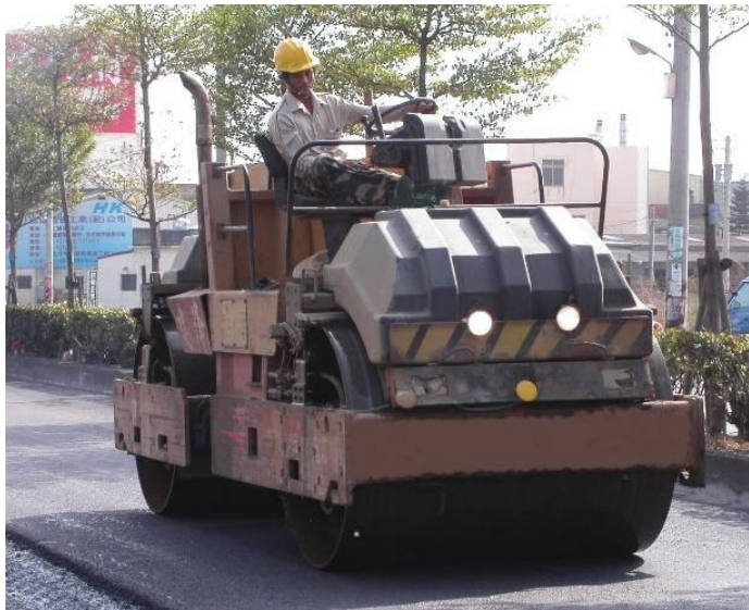
二輪壓路機(終壓)消壓紋、改善平坦性(不得低於 65^{\circ}\text{C} )
