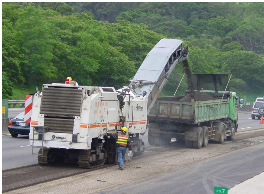
冷式刨除機 刨除 損壞舊瀝青路面
