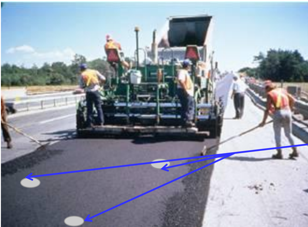
AC運至現場量測瀝青混凝土溫度
