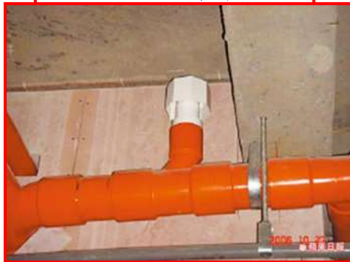
圖1-5 吸氣閥構造圖例
