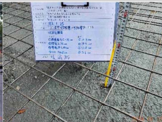
(3)鋪設銲接鋼線網
