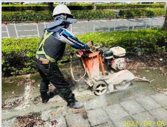
(1)打除既有鋪面
