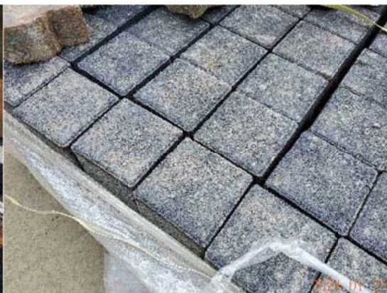
高壓磚替代水泥砂漿墊塊
