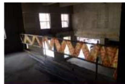
挑空區設置欄杆
