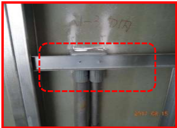
◆管線開口加勁及出線盒加強鎖固及維持結構強度
