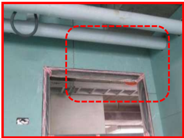
◆開口外角隅整板鋪貼(菜刀柄板狀)增加耐久性
