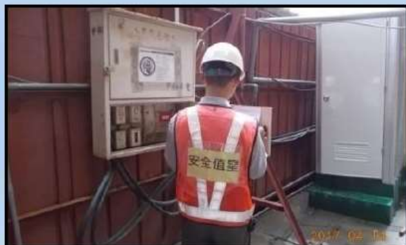
工地自主巡檢
