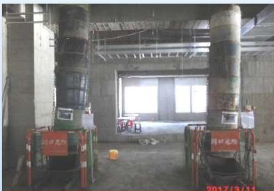
分類垃圾管道
