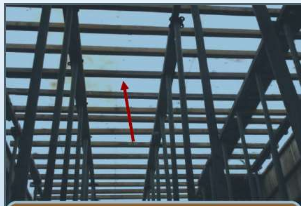
模板使用採光板 減省施工照明需求
