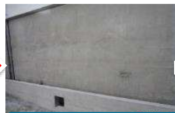
外牆1:2防水粉刷施作
