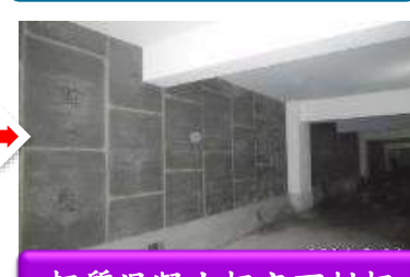
輕質混凝土板交丁封板
