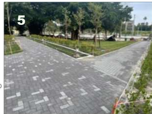
5 3-5cm襯墊細碎石+6cm高壓透水磚
