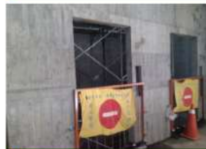
電梯開口設置護欄
