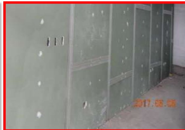
◆隔間板材採錯位搭設
