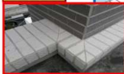
屋頂泛水收邊轉角施作
