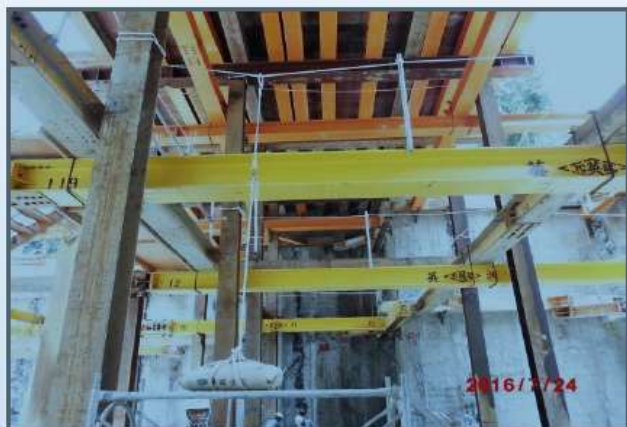
要求水平支撐立柱安全母索吊掛試驗 (5分特多龍繩)
