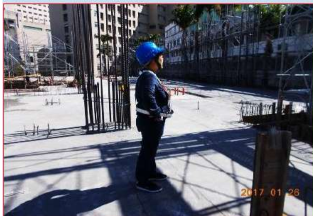
施工架組配作業主管在場監督
