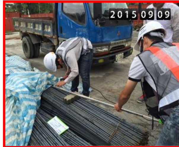
鋼筋囤儲防水布覆蓋
