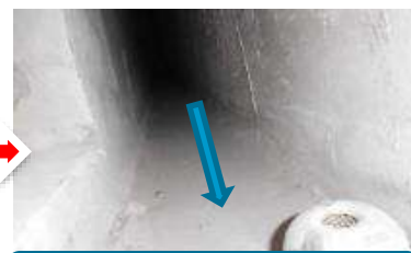
複壁內排水溝洩水粉刷
