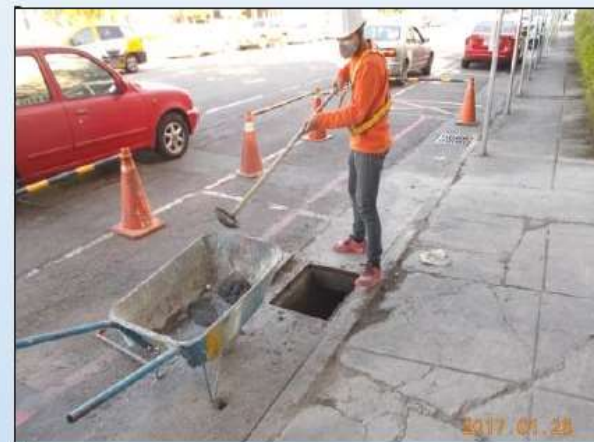
定期排水溝清淤 維持周邊排水通暢
