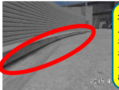
5公分厚PS隔熱板+濾水布及 點焊鋼絲網鋪設
