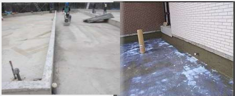
施工前研磨清潔，落水頭補強
