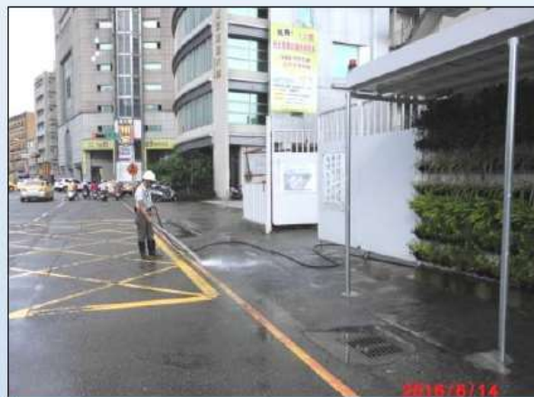
清洗道路 維持工區周路道路清潔
