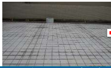
5公分厚PS隔熱板+濾水布及 點焊鋼絲網鋪設
