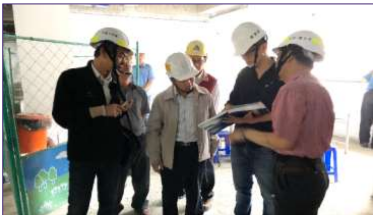
中區工程處現場職安抽查
