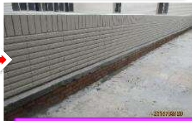
泛水壓緣磚施作
