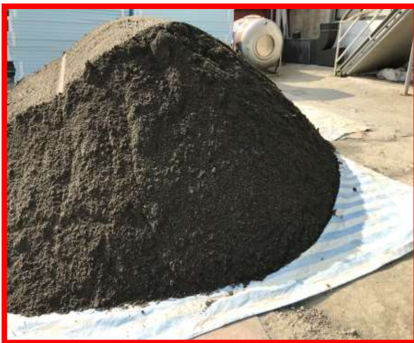
泥作用砂防水布隔離
