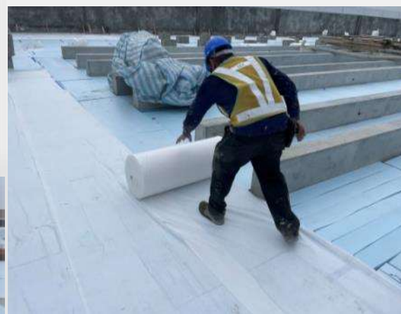
濾水布(T=1.0mmTH)密接鋪設
