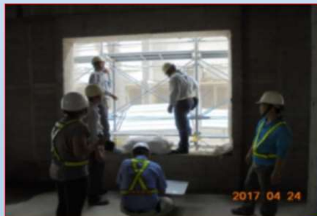
施工架與結構體空隙防墜網75kg沙 包檢測
