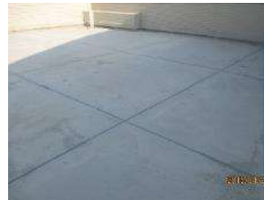
防水PC保護層作3M*3M伸縮縫切割，再以PU填縫，減少混凝土裂縫延伸。
