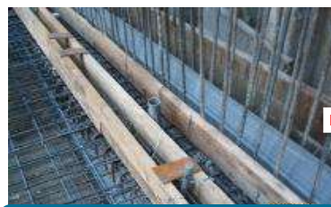
複壁止水墩吊模一次RC
