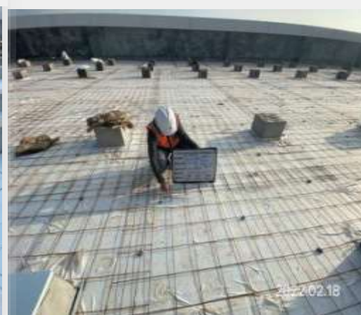
點焊鋼絲網20*20*4mm+混凝土澆置
