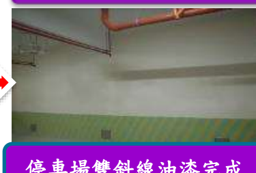
停車場雙斜線油漆完成
