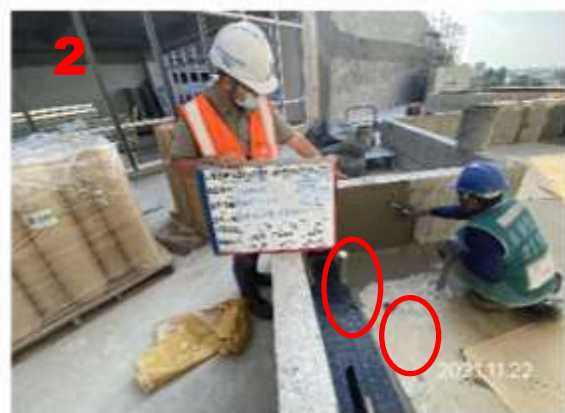
角隅及水管加強防水
