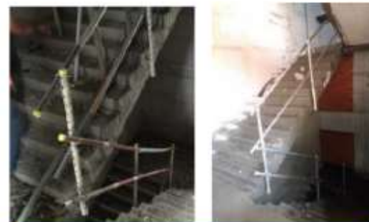
樓梯設置欄杆
