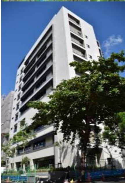
施工期間 以阻根鋼 板防止竄 根
