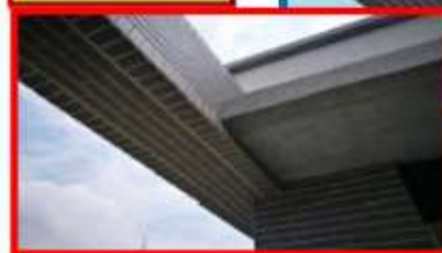
屋頂懸梁底面滴水線收邊
