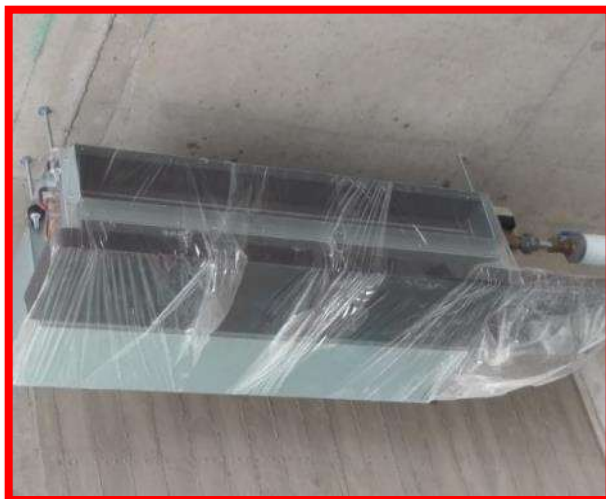
空調送風機防塵作業
