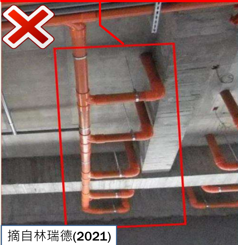
污水管轉彎處採1只90度彎頭
