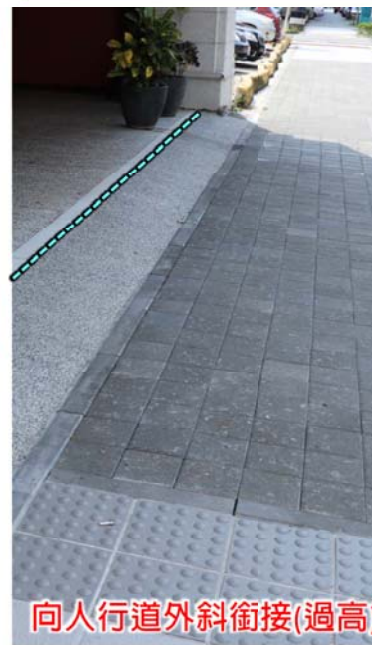
騎樓高於設計後人行道5-20CM，採退縮地坵石子收邊1/2斜坡銜接修順，或採階梯方式
