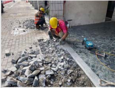
(1)打除既有鋪面
