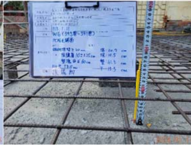
(3)鋪設銲接鋼線網
