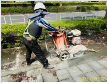
(1) 打除既有鋪面
