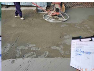
(6) 面層澆置後粉光拉毛
