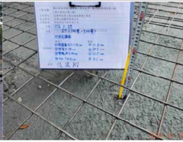
(3) 鋪設銲接鋼線網
