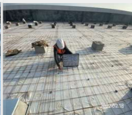
點焊鋼絲網20*20*4mm+混凝土澆置
