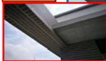
屋頂懸梁底面滴水線收邊
