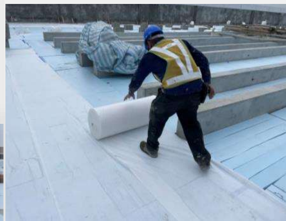
濾水布(T=1.0mmTH)密接鋪設
