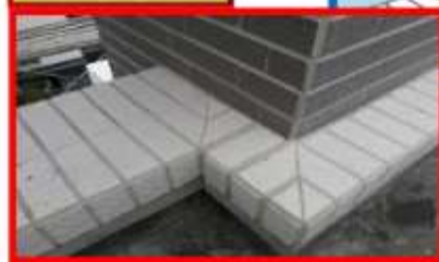
屋頂泛水收邊轉角施作
