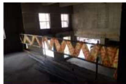
挑空區設置欄杆
