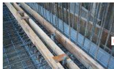
複壁止水墩吊模一次RC
