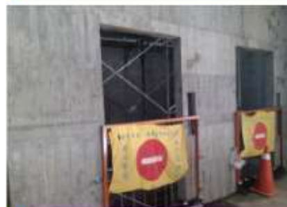
電梯開口設置護欄
