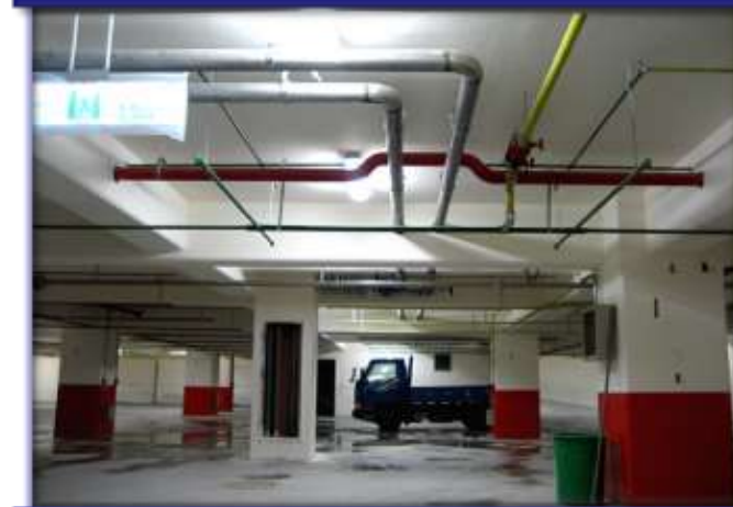
現場完成實景
