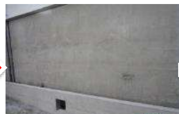
外牆1:2防水粉刷施作
