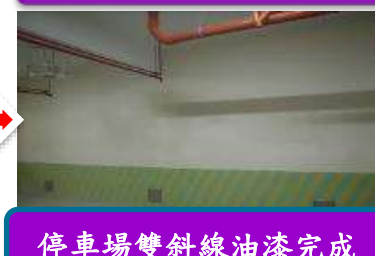
停車場雙斜線油漆完成
