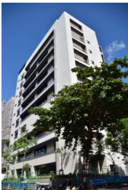
施工期間以阻根鋼板防止竄根
