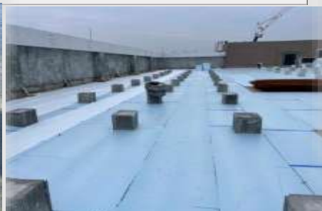
PS隔熱板(T=2.5cmTH)密接鋪設
