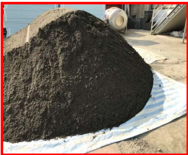
泥作用砂防水布隔離
