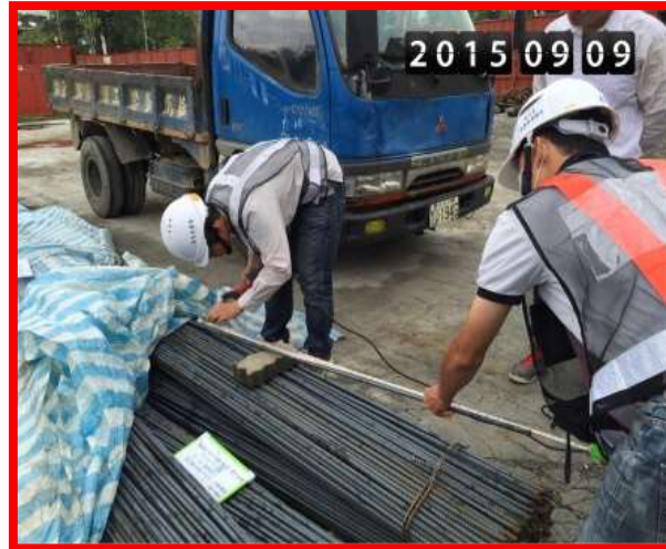
鋼筋囤儲防水布覆蓋
