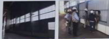
門扇吊裝完成及運轉測試
