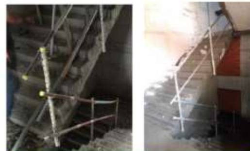
樓梯設置欄杆
