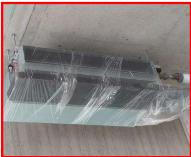
空調送風機防塵作業
