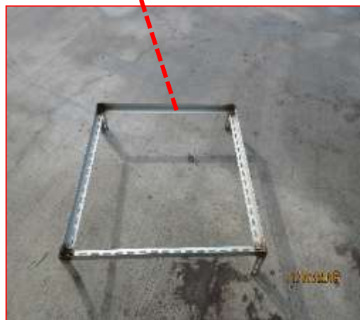
製作邊框 確保人孔蓋水平
