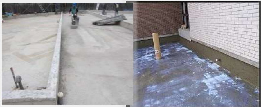
施工前研磨清潔，落水頭補強
