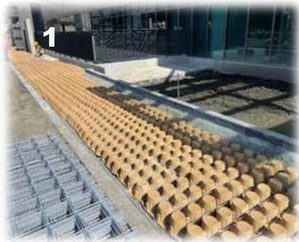
1 底層夯實+清碎石透水層+鋪設透水紙模+點焊鋼絲網
