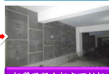
輕質混凝土板交丁封板
