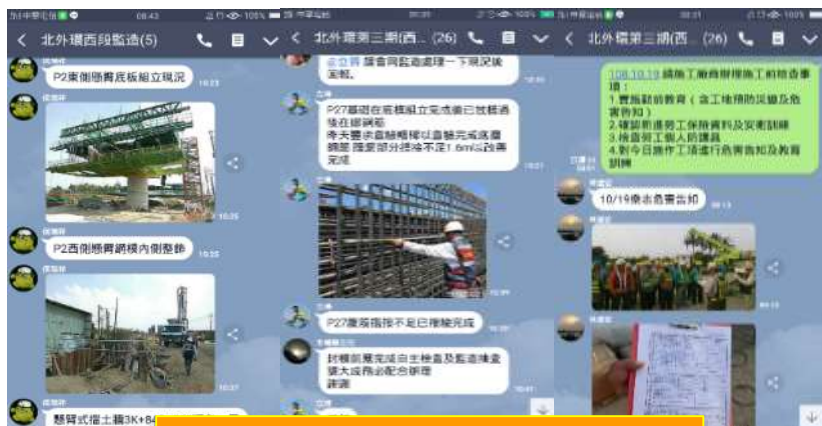
透過LINE平台逐日回報施工及危害告知現況
