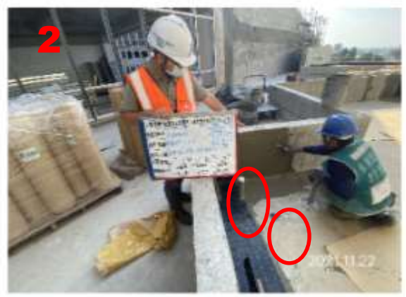
角隅及水管加強防水
