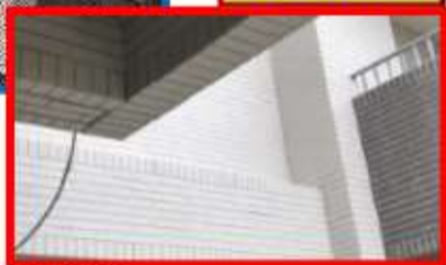
陽臺雨遮滴水線收邊
