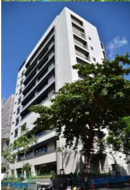
施工期間以藍根鋼板防止竄根
