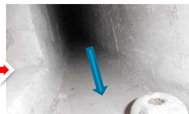
複壁內排水溝洩水粉刷
