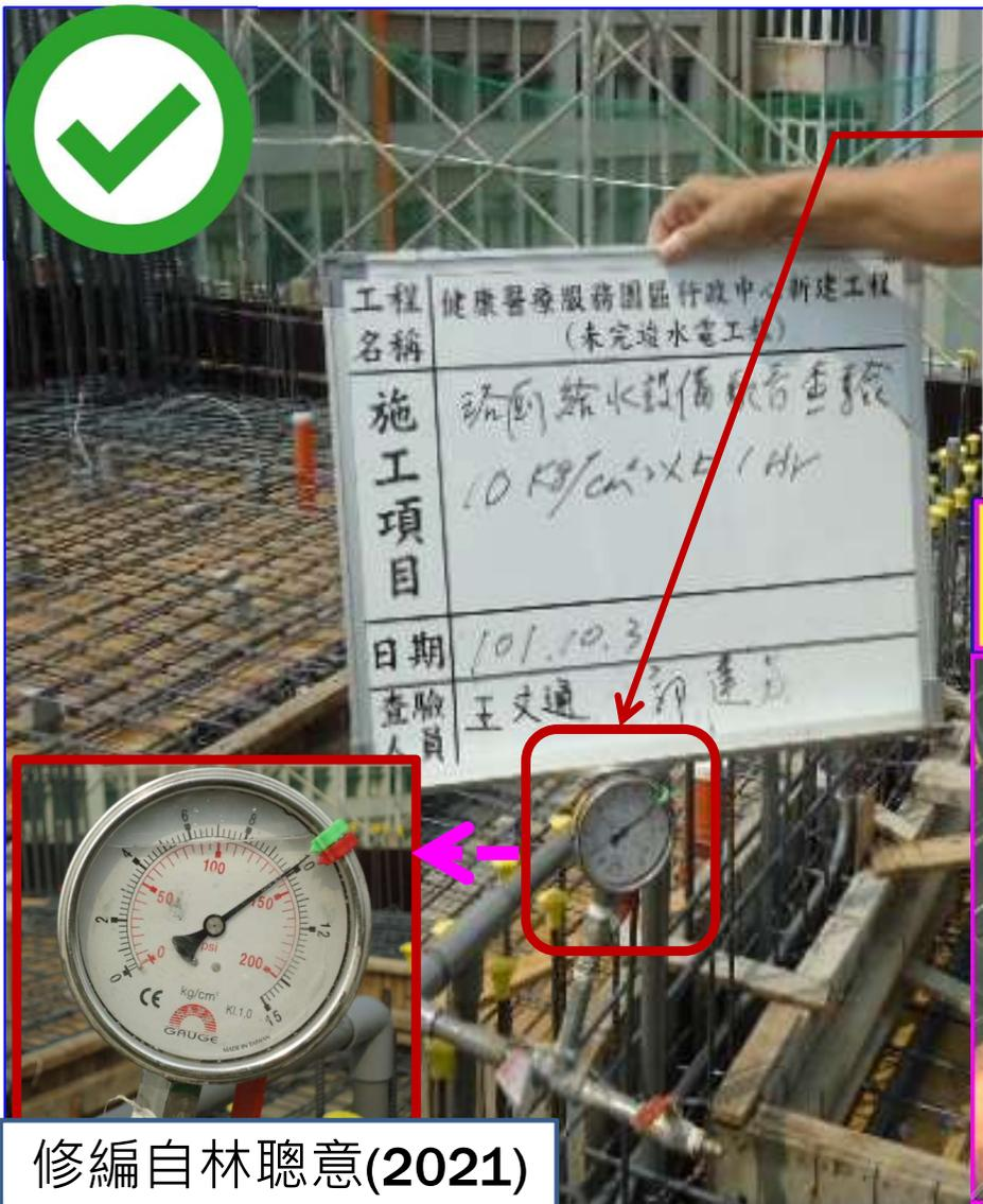
給水系統試水試壓
