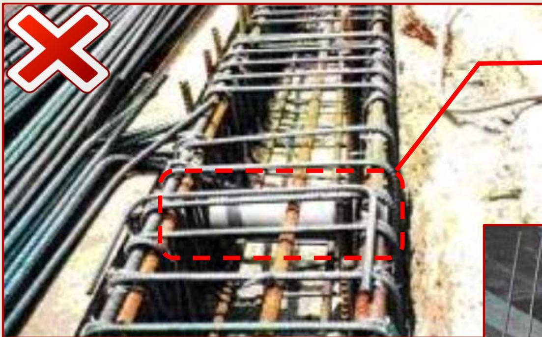
管線穿越外牆處，管圍未加設**止水環**
