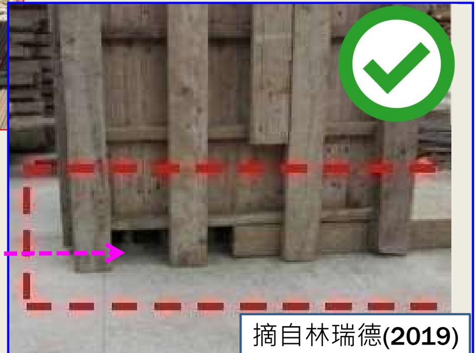
柱模底部設置清潔孔
