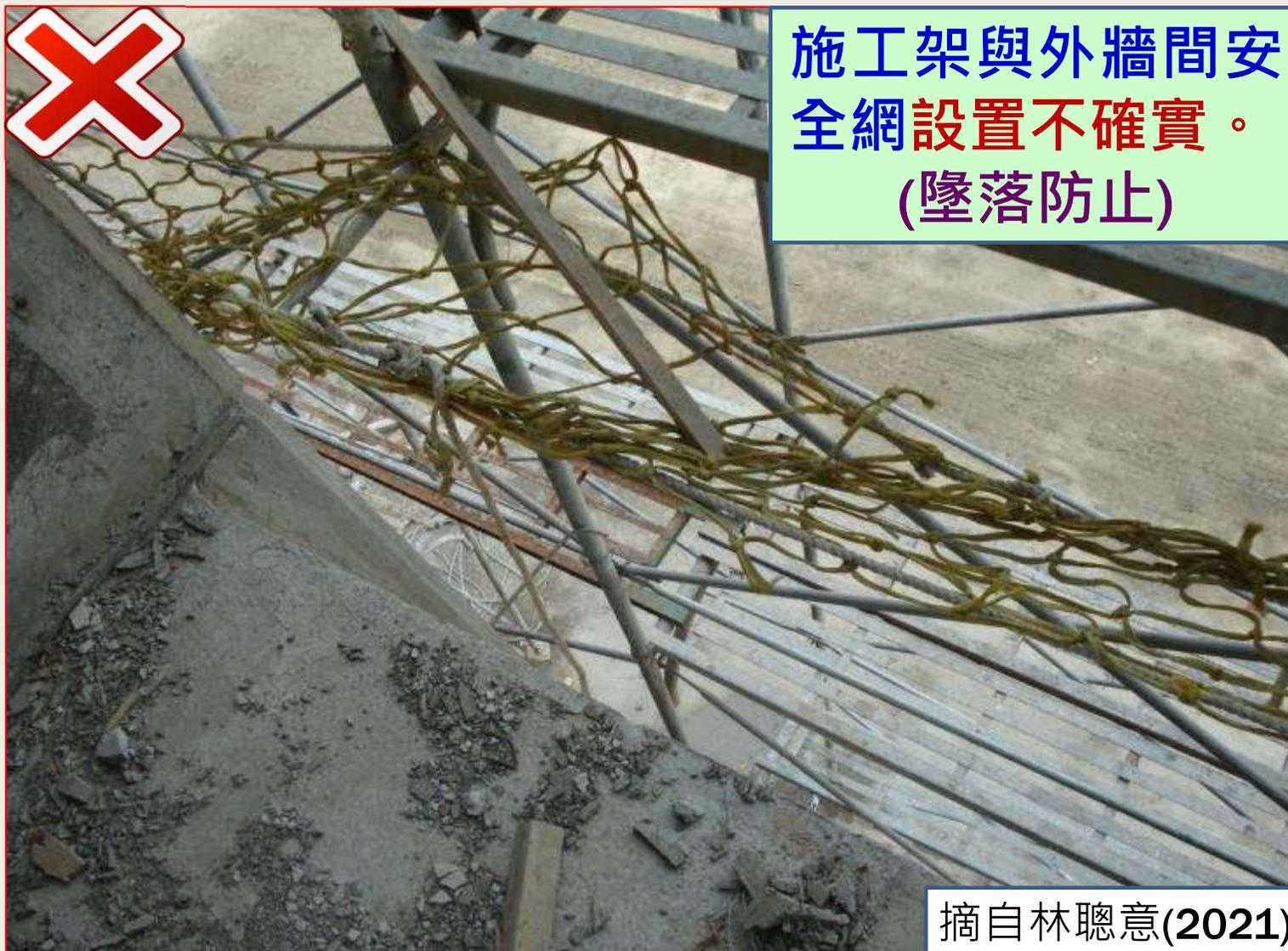
施工架與外牆間安全網設置不確實。
