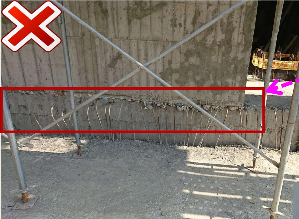
牆混凝土底部夾雜
