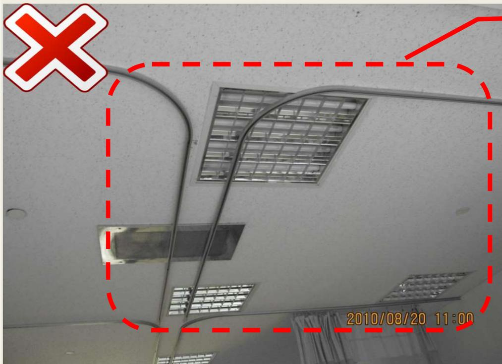
水電、土建施工介面未整合。布簾軌道固定在燈具上，燈管不易更換。
