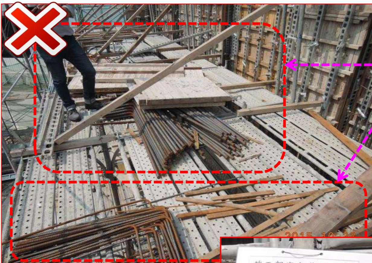
施工架踏板上，置放有鋼筋和雜物等，有飛落之虞。
