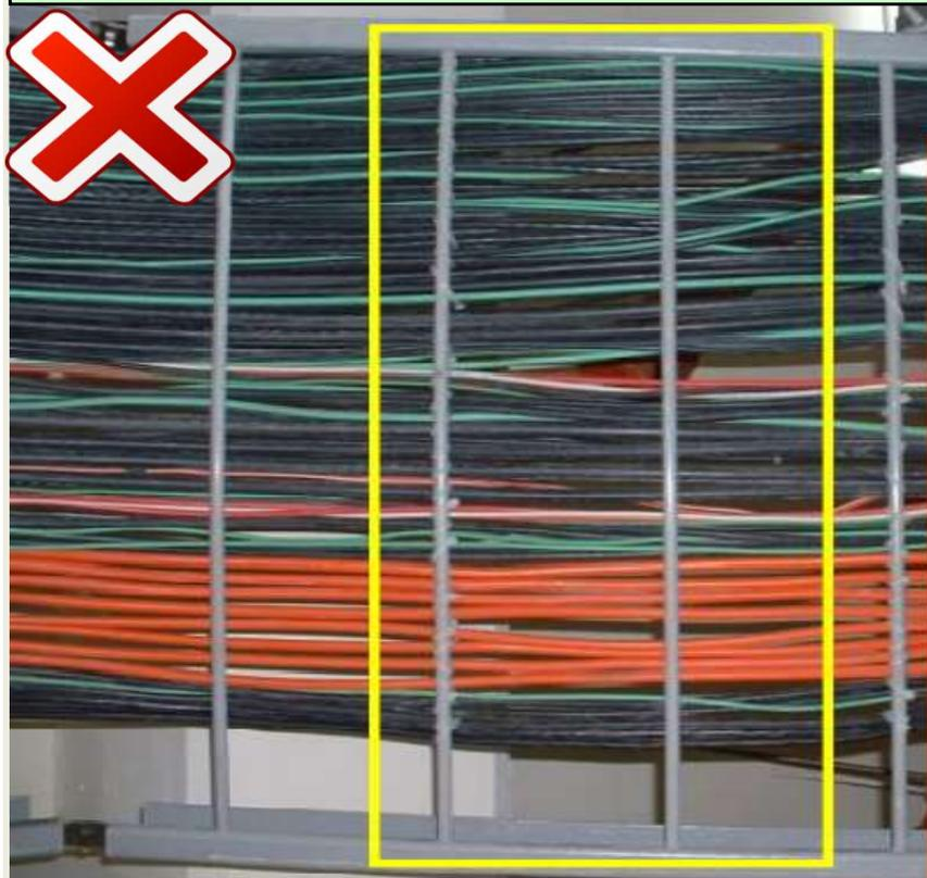
電纜架線路應標示來源及去處。水平裝置之金屬導線槽，應在每距1.5公尺處，加一固定支持。
