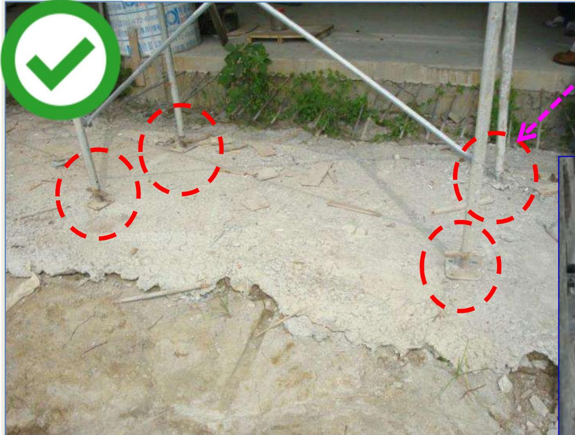
施工架設置可調型基腳座板且基礎鋪設PC或鋼板
