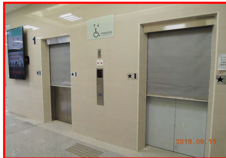
火災時電梯安全連動
