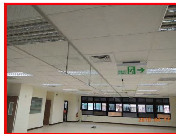
空間設置小型吊掛送風機 分區彈性使用與節約能源
