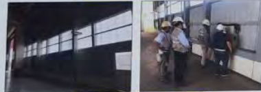
門扇吊裝完成及運轉測試
