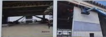
門扇吊裝作業
