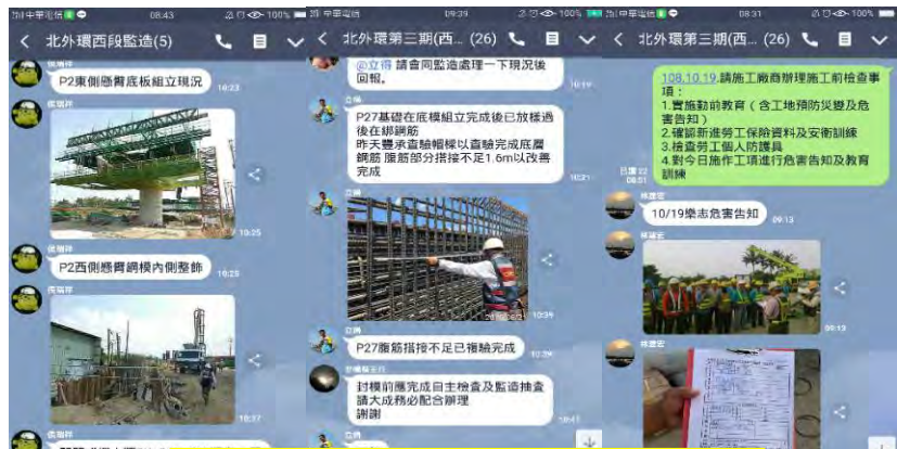
透過LINE平台逐日回報施工及危害告知現況
