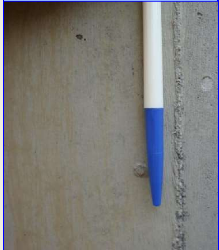
施作良好情形
