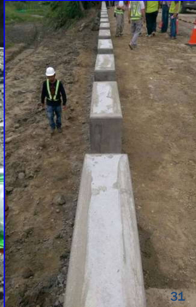
施作良好情形
