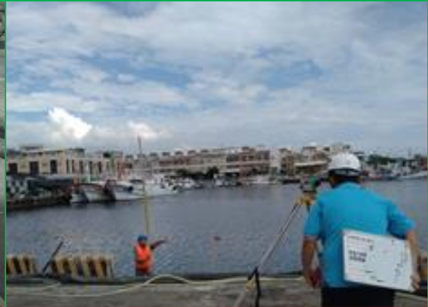
板樁打設高程檢查
