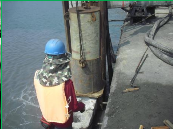
版樁樁錘施作
