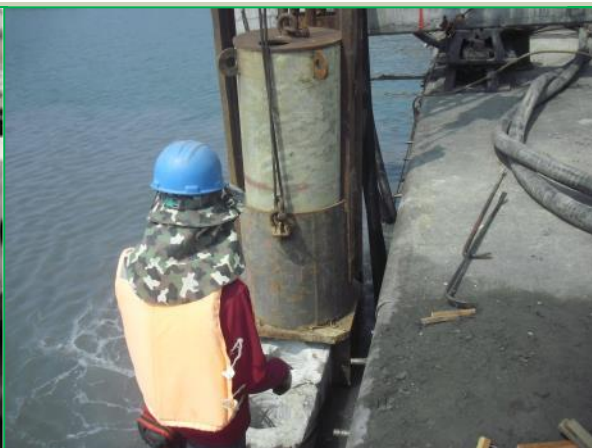
版樁樁錘施作
