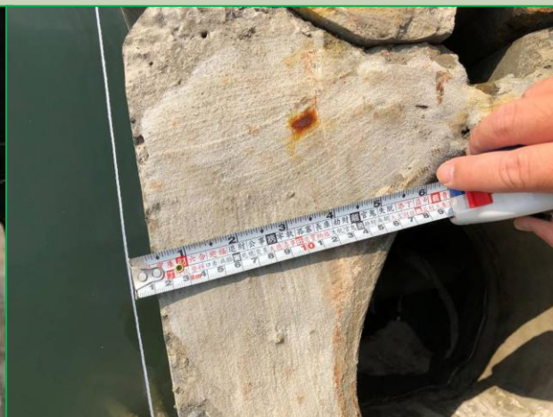
樁直線偏差檢查
