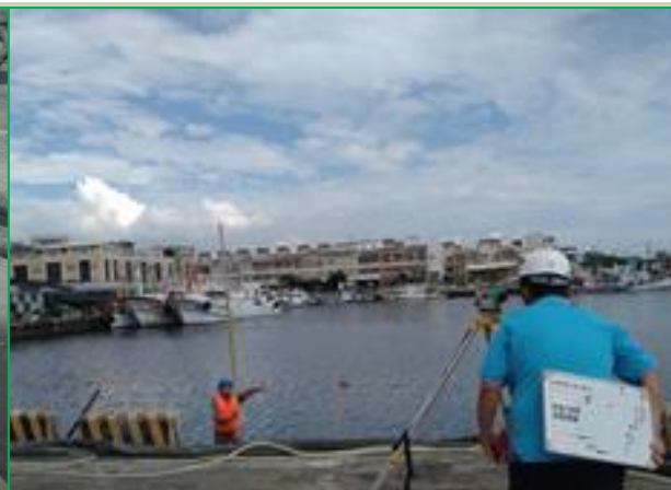
板樁打設高程檢查
