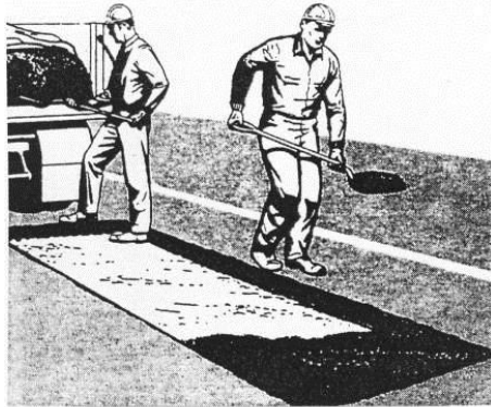
鋪設瀝青混凝土
