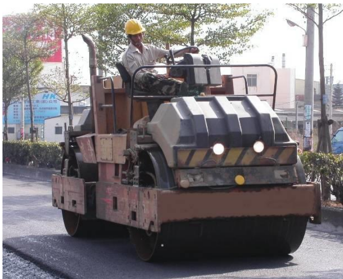
二輪壓路機(終壓)消壓紋、改善平坦性
