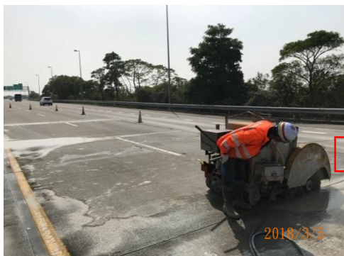
混凝土板塊鋸切
