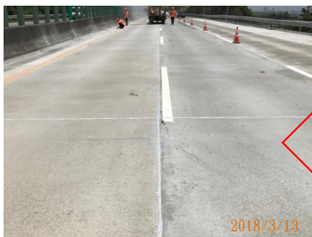
板塊更新完成
