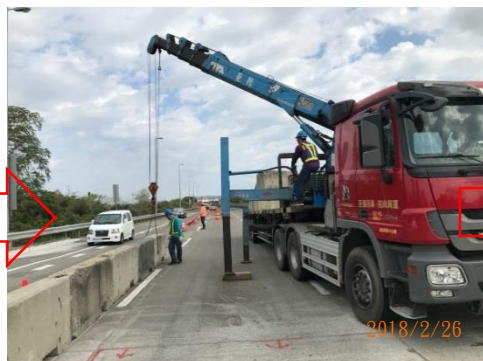
紐澤西護欄吊放
