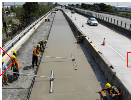
快凝混凝土整平
