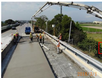
快凝混凝土澆置
