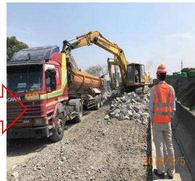
混凝土版塊運棄
