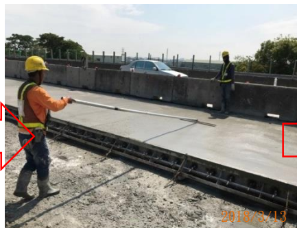
快凝混凝土刮槽
