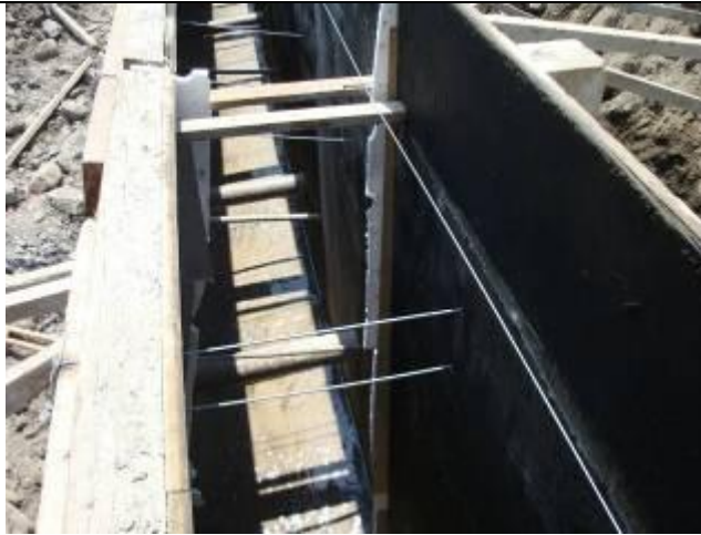
擋土牆未確實設置伸縮縫，伸縮縫施作僅在表面貼設保麗龍，中央部分以保麗龍隔開
