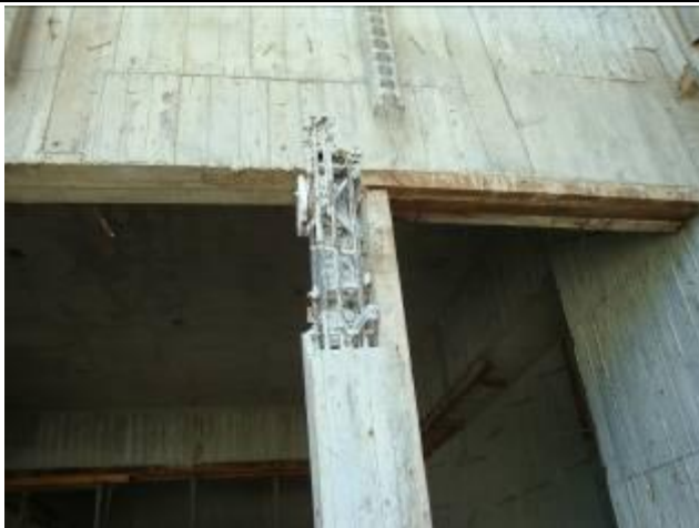
牆面混凝土澆置不良，有孔洞
