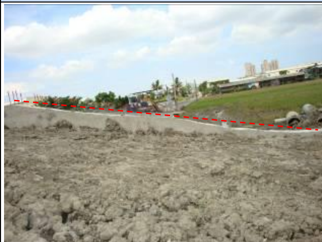
護岸混凝土完成面不平整
