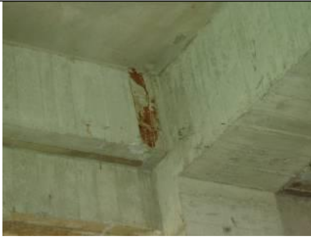
梁混凝土表面殘留補縫夾板
