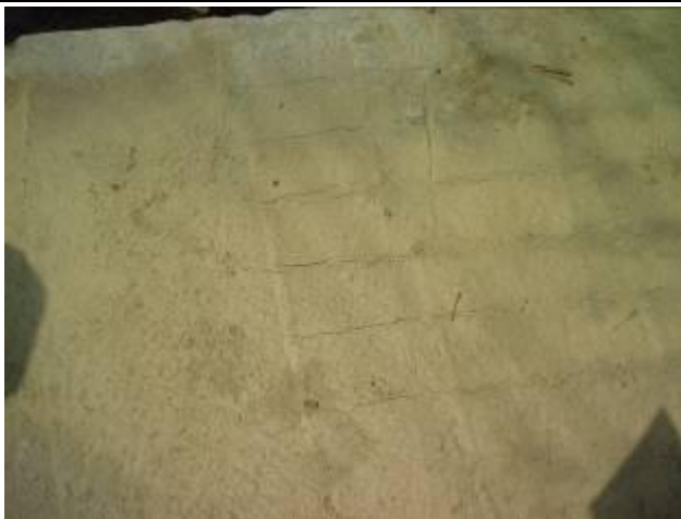
(可能保護層不足或為塑性沉降裂縫)
