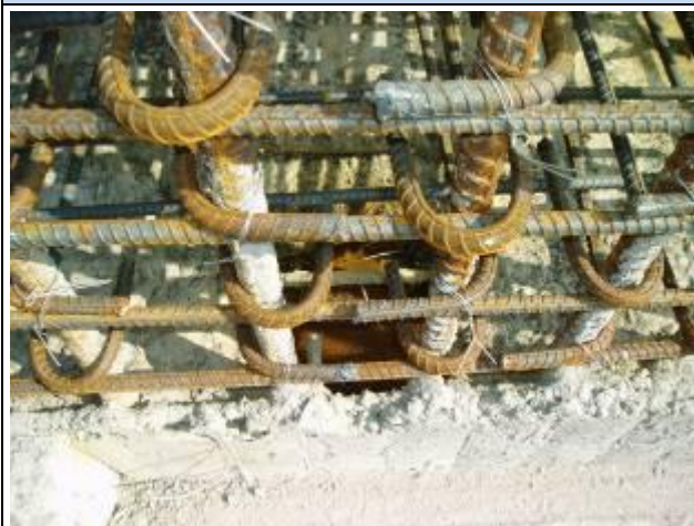
建築工程混凝土完成面不佳照片
