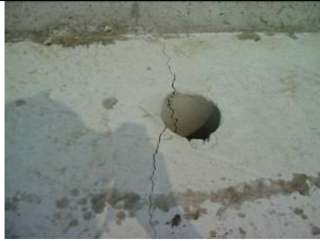
排水孔邊裂縫
