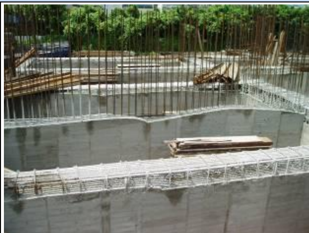
建築工程混凝土完成面不佳照片
