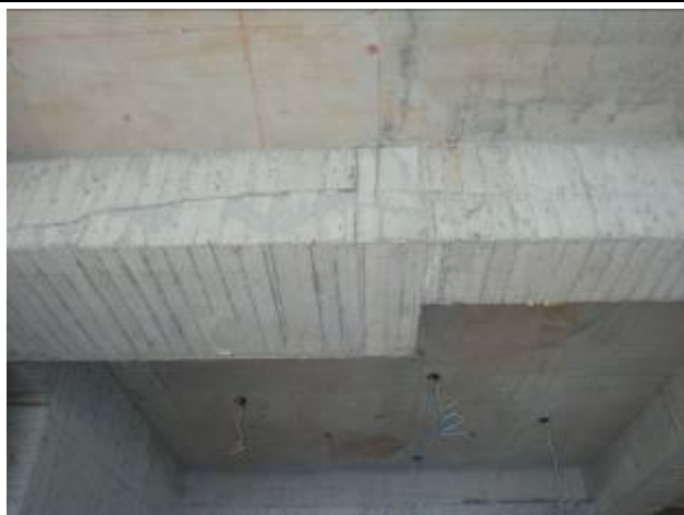
梁混凝土有冷縫產生
