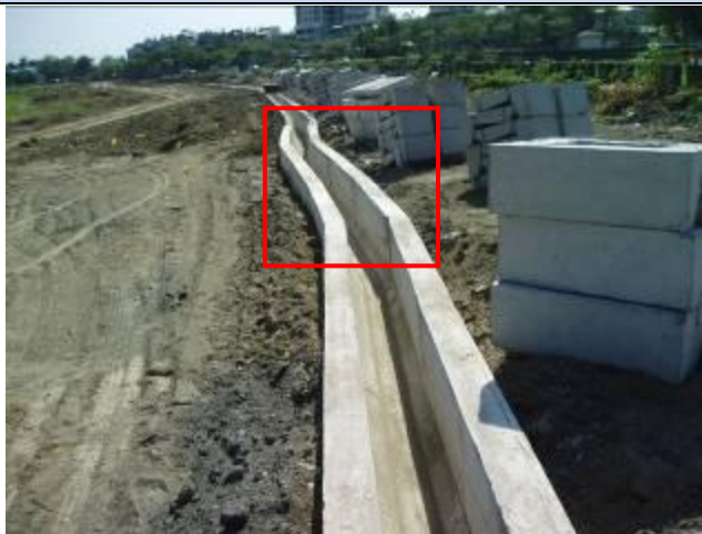
側溝線形歪曲，不平順（應拆除重作）
