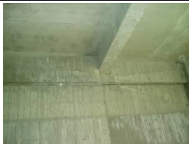
梁及牆混凝土有冷縫產生
