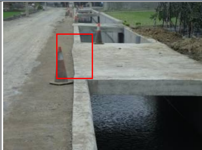
明溝混凝土邊緣線因模板爆模，導致完成面歪斜凸出於路面
