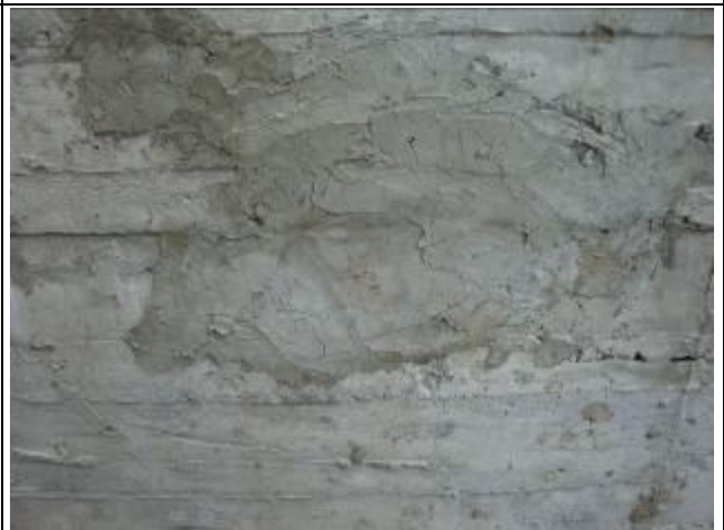
修補材料配比不對或使用水泥漿，產生龜裂，應使用原混凝土同一比例之水泥砂或混凝土
