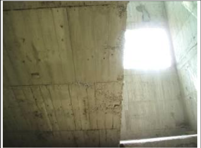
樓梯底部混凝土澆置不良，有蜂窩
