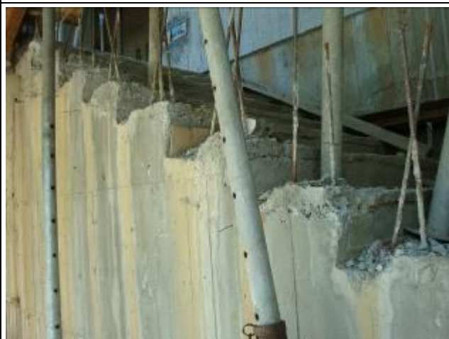
樓梯級高管控不良，高度不一
