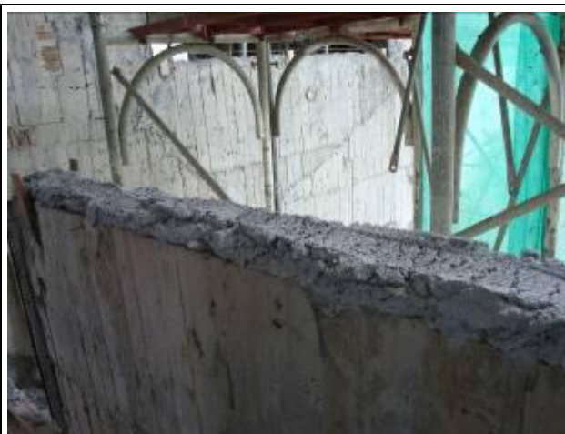
窗台混凝土澆置高度不足
