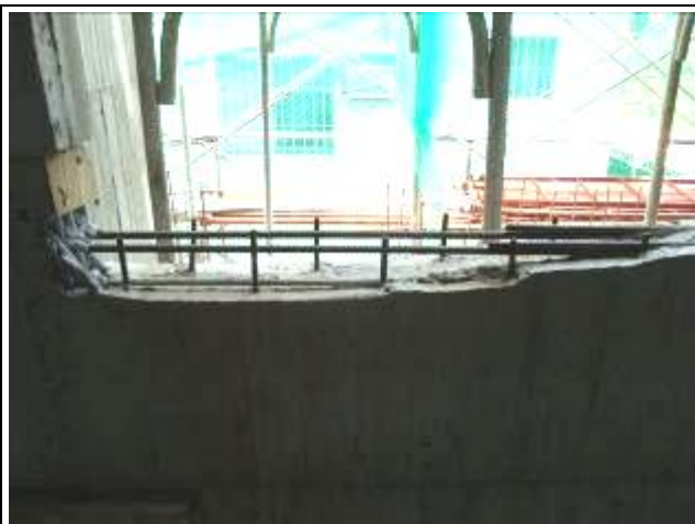
窗台混凝土澆置高度不足
