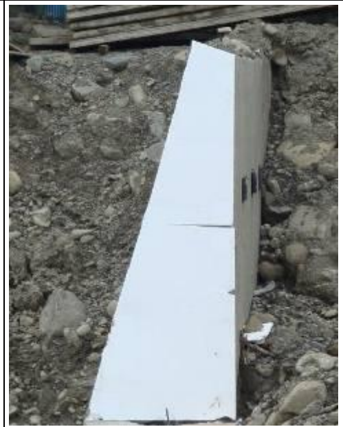
擋土牆混凝土伸縮縫施作不當，僅表面處有隔開，中央部分未確實隔開
