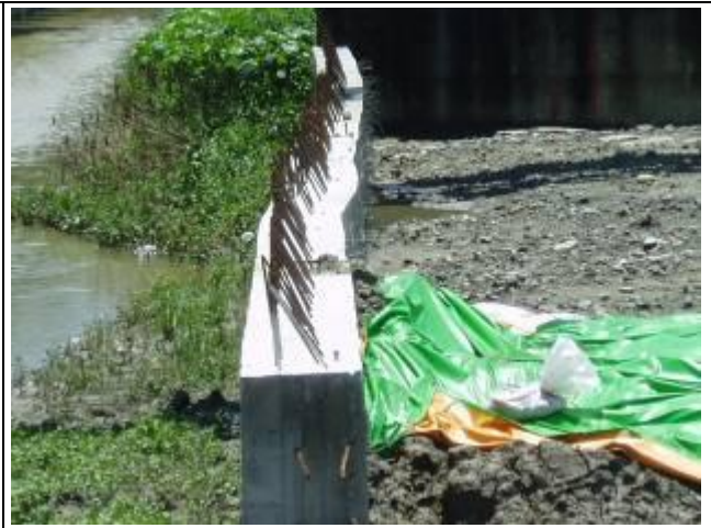
擋土牆完成面線形不平直（應拆除重作）
