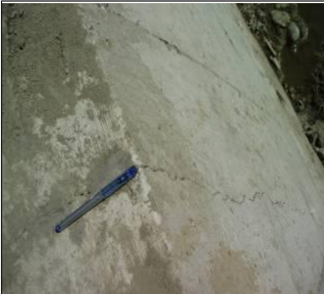
擋土牆完成混凝土面多處產生龜裂現象
