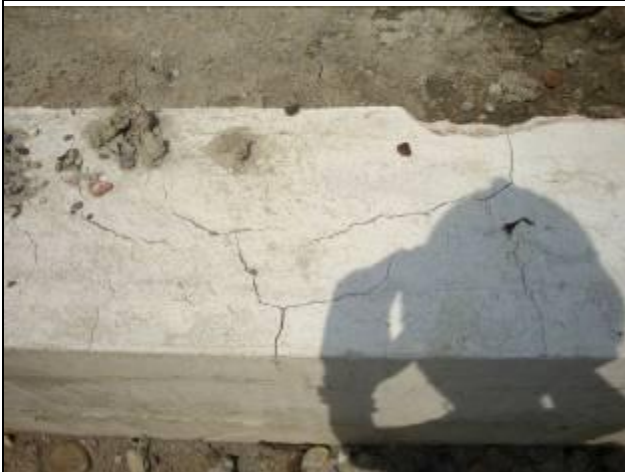
擋土牆龜裂缺失照片
