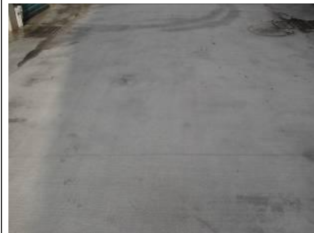
施作良好無裂縫情形
