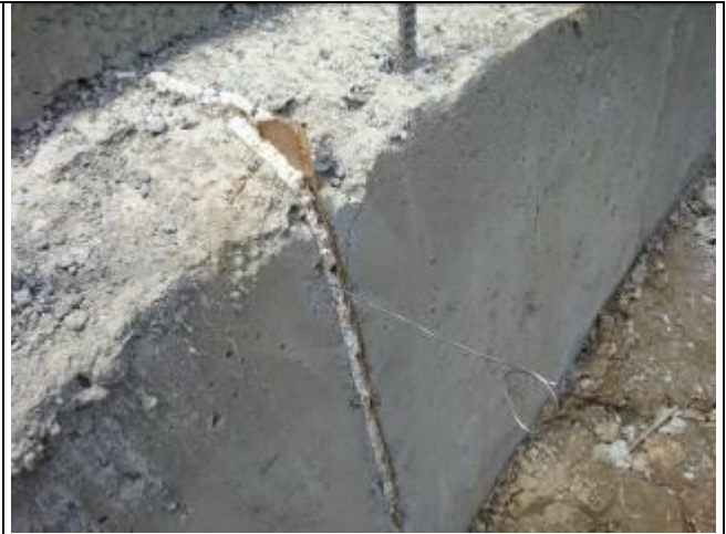
擋土牆混凝土伸縮縫施作不當，僅表面處有隔開，中央部分未確實隔開
