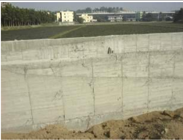
擋土牆混凝土澆置、搗實不合規範，有多道冷縫產生
