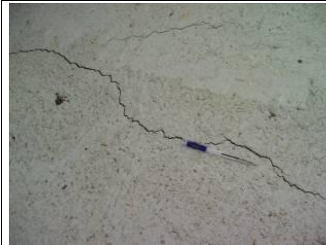
混凝土路面(鋪面)有裂縫
