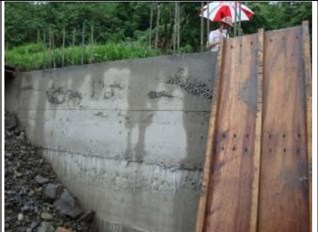
擋土牆混凝土澆置不良，有蜂窩
