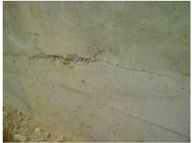
冷縫情形嚴重，產生不連接面
