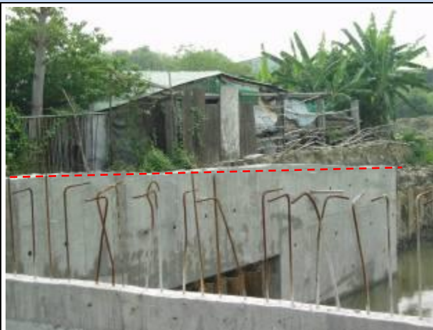
擋土牆混凝土完成面高程控制不佳，頂部有高低起伏
