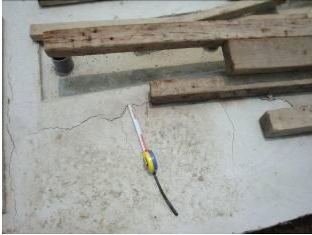
側溝龜裂照片
