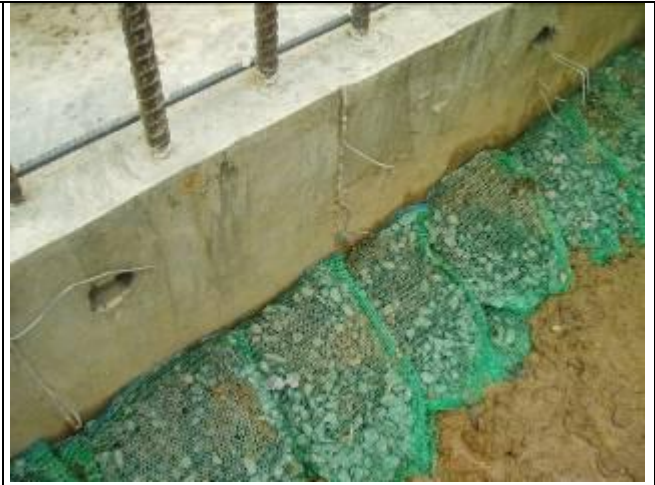
擋土牆回填土側混凝土表面殘留鐵絲
