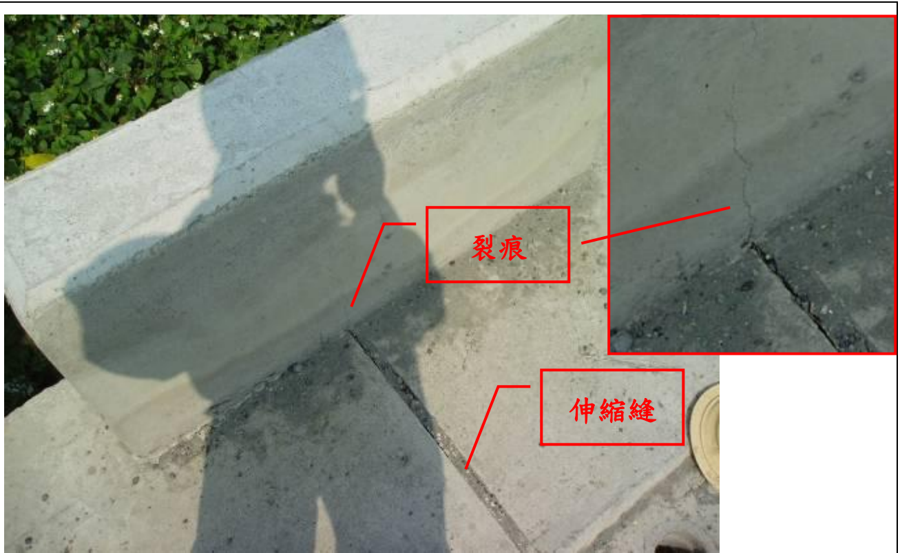
側溝伸縮縫間距與護欄尺寸未搭配，致護欄座落於伸縮縫上，護欄於伸縮縫處產生裂痕
