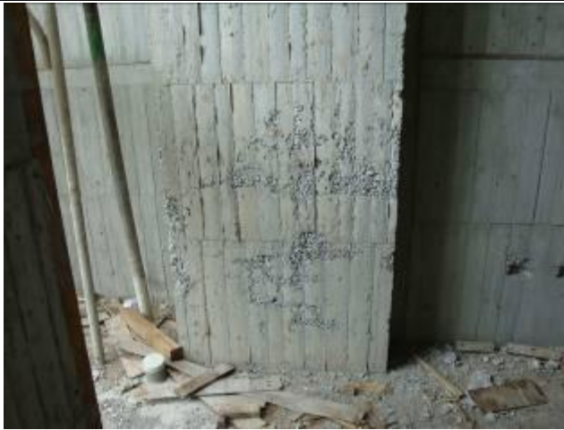
柱腳混凝土澆置不良，有蜂窩
