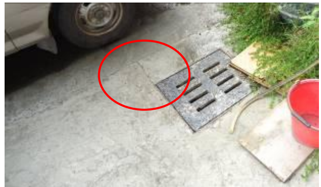
溝蓋角隅裂縫
