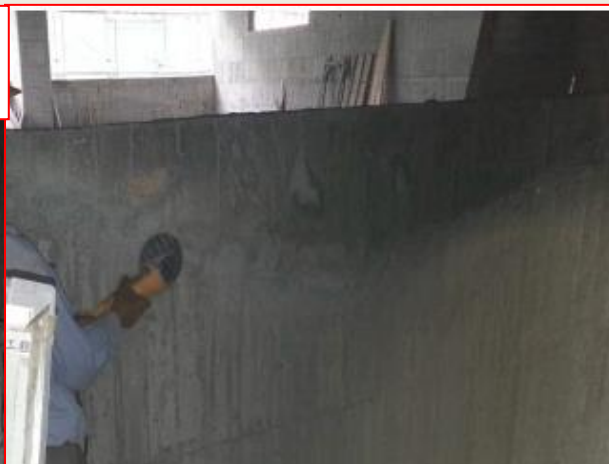
混凝土面整修
