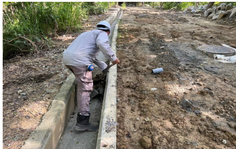
高雄市內門觀光休閒園區新建工程 -工區內排水溝清疏
