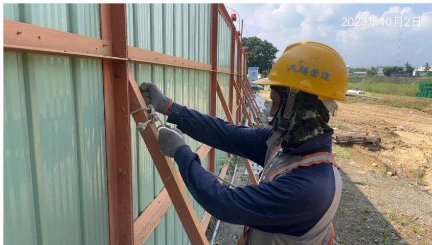
觀音湖內埤生態廊道營造工程 -施工圍籬加強檢查與固定
