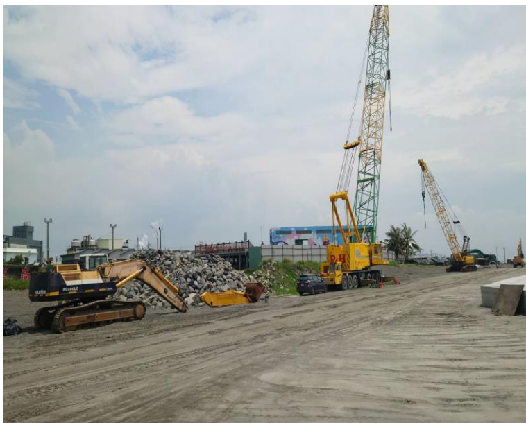
施工機具擺放安全位置固定。
