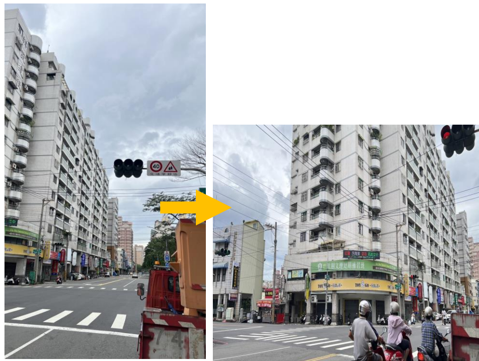
鳳山區八德路/文衡路號誌不亮修復
