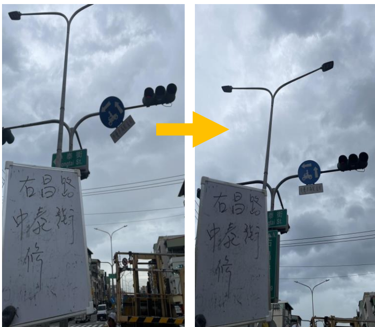
楠梓區右昌街/中泰街機兩段標誌修復
