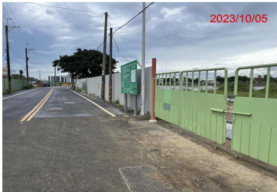
觀音湖內埤生態廊道營造工程
