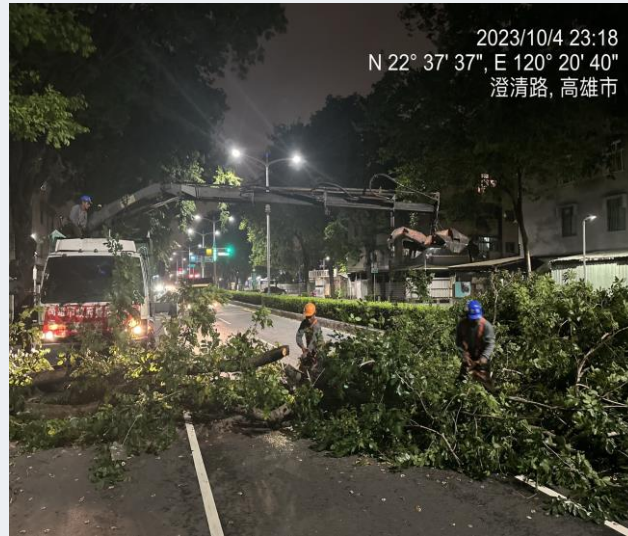
鳳山區/澄清路74巷口
