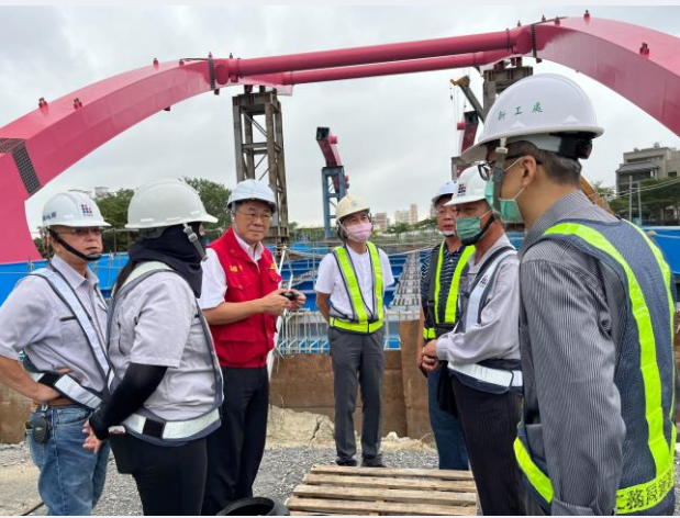
三民區/龍德新路橋梁工程
