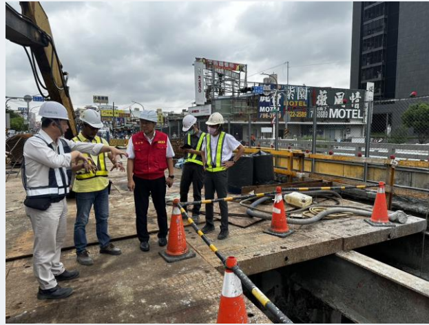
前鎮區/媽祖港橋改建工程
