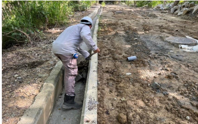
高雄市内門觀光休閒園區新建工程 -工区内排水溝清疏
