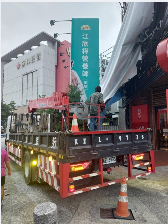
左營區新庄仔路、博愛三路口 / 帆布拆除
