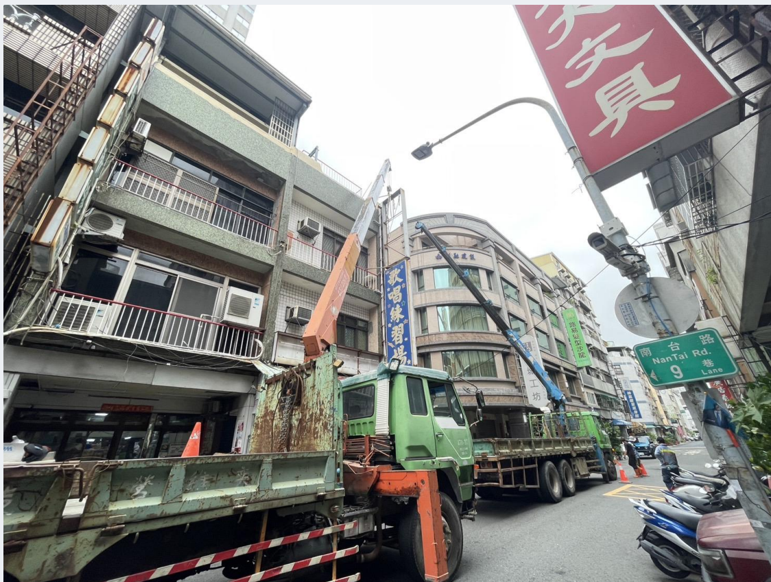
新興區南台路9巷 / 廣告招牌拆除
