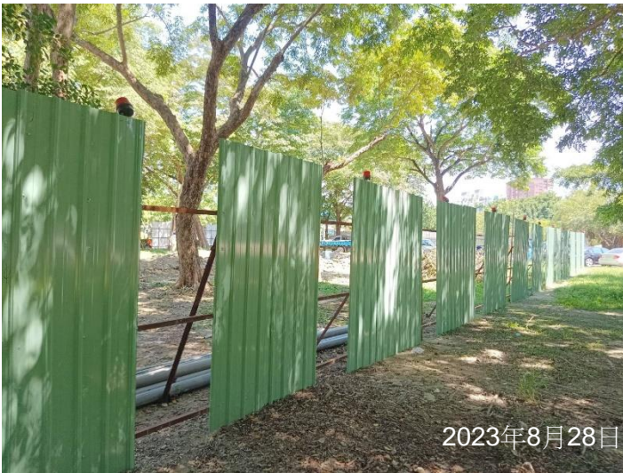
111年度高雄市風景區特色遊憩場營造 統包工程(蓮池潭兒童公園) -甲圍部分拆除減少風阻
