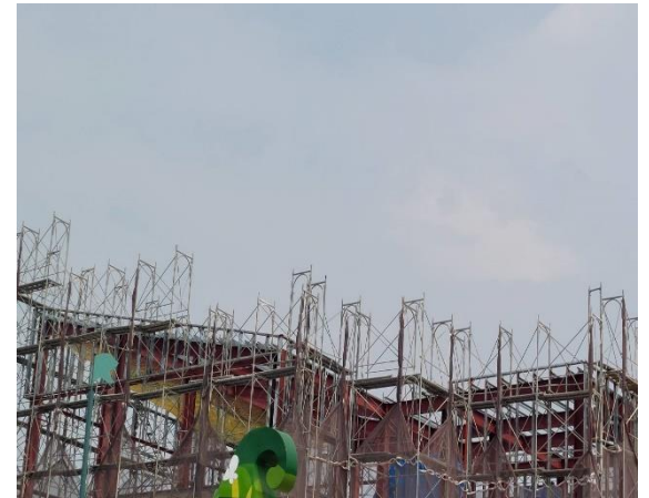
施工架防護網拆卸
