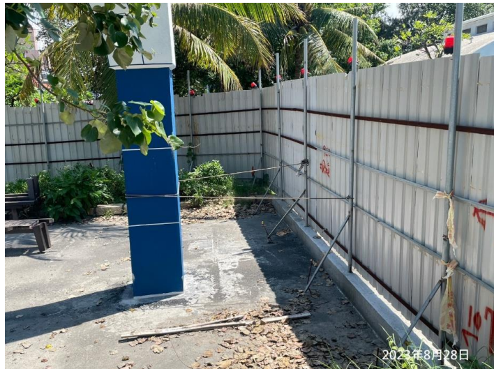
111年度旗津環境改善工程 -施工圍籬加強檢查與固定
