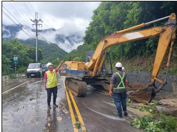
高132線沿線落石坍塌 現場清除作業已完成
