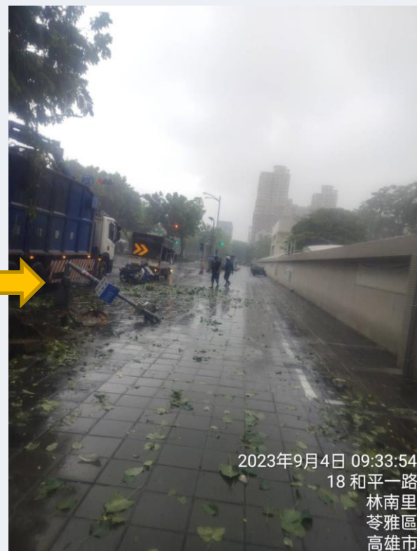
處理完成/原復道路通行
