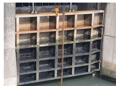
改以手拉吊車進行操作因應
