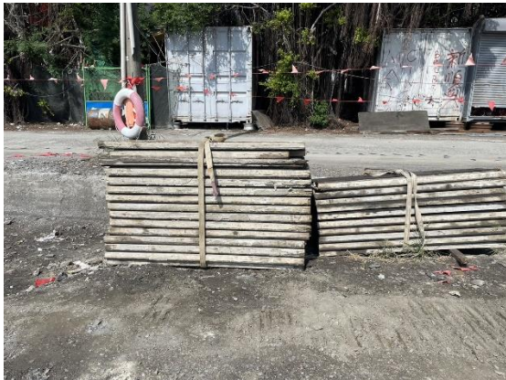
模板堆置後綁紮固定
