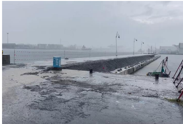
工區內所有雜物已清除
