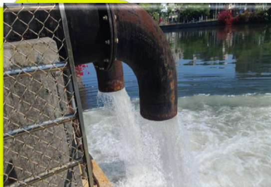
抽水機運轉測試
