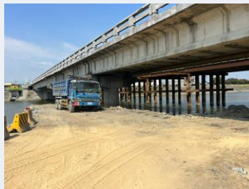
舊港橋改建工程
