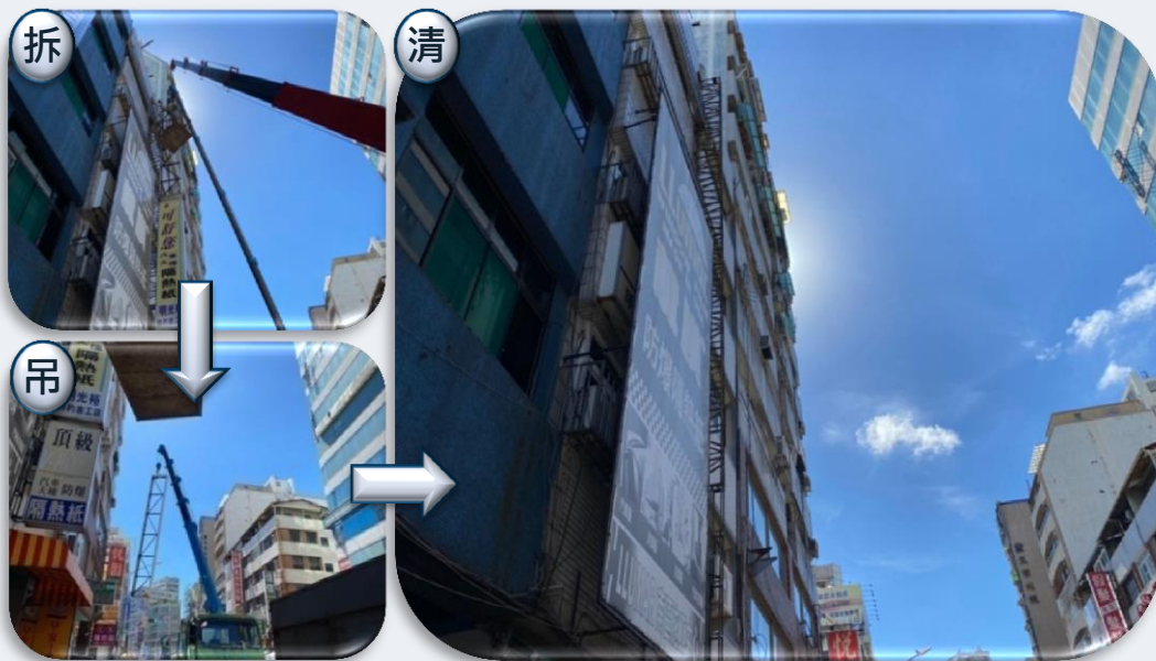
廣告招牌拆除
