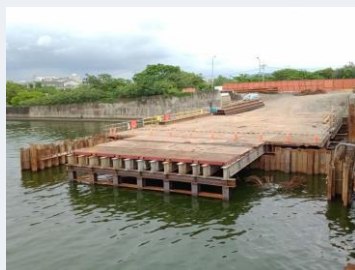
通安大橋改建工程
