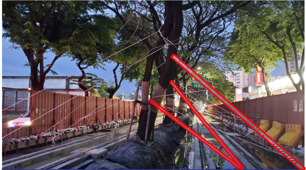
目前已支撐加固路口(聯興路)
