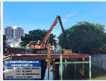
龍德新路拓寬及往東延伸 跨越愛河橋梁工程
