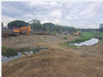
笕橋改建工程
