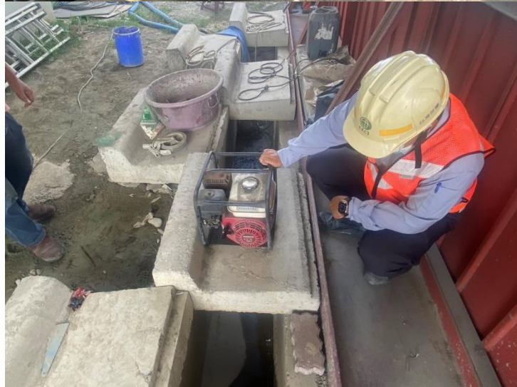
岡山路竹延伸線工區物料整理加 固、抽水設備功能檢查
