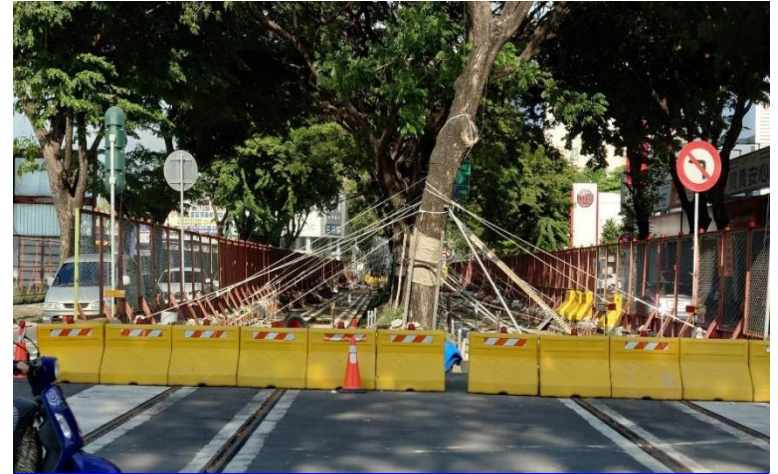
輕軌施工路段兩豆樹加固
