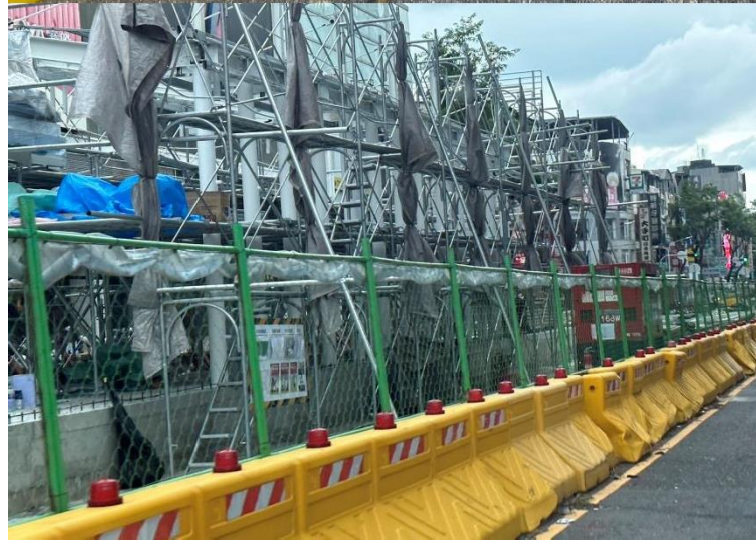
輕軌二階工區施工架帆布拆除、 紐澤西護欄注水及檢查
