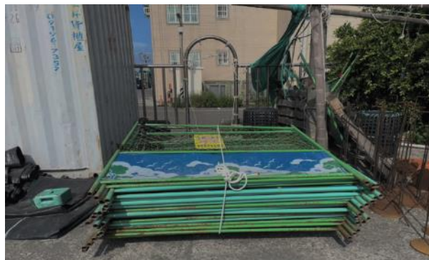
圍籬已拆除捆紮牢固
