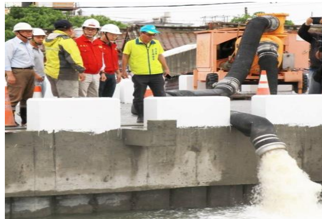
永安區新港里預佈移動式抽水機
