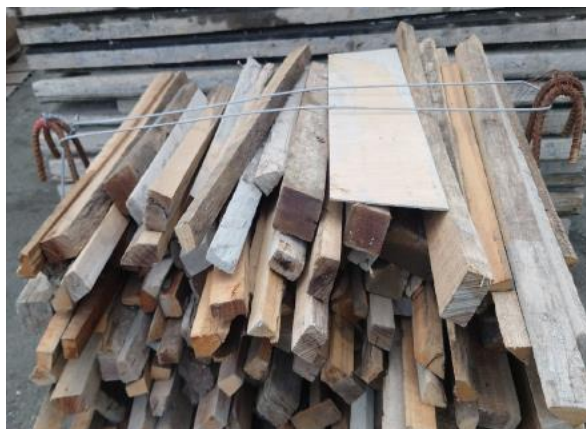
材料設備已捆紮牢固
