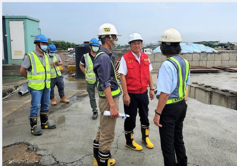
◆ 中油土污整治工程
