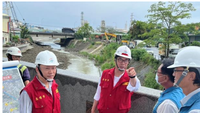
楠梓及仁武後勁溪仁武橋
