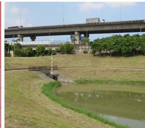
獅龍溪滯洪池
