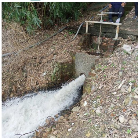
內埤閘門修復完成
