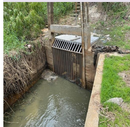
外埤閘門修復完成
