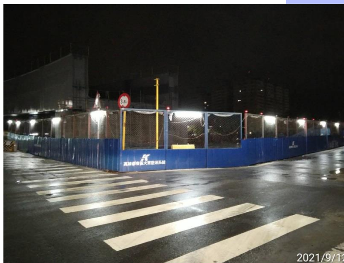
岡山路竹延伸線一階工區現況
