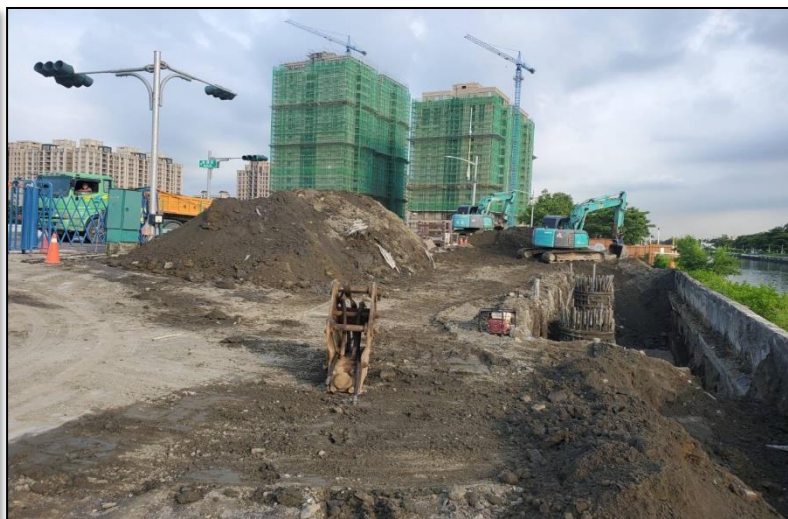
前鎮運河銜接凱福街車行橋-2
