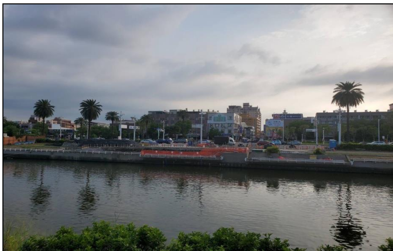
前鎮運河銜接凱福街車行橋-1
