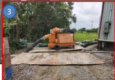
設置1台移動式抽水機
