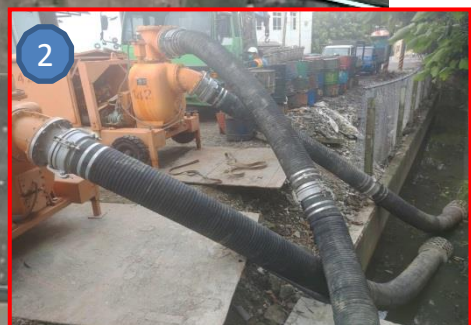
設置4台移動式抽水機
