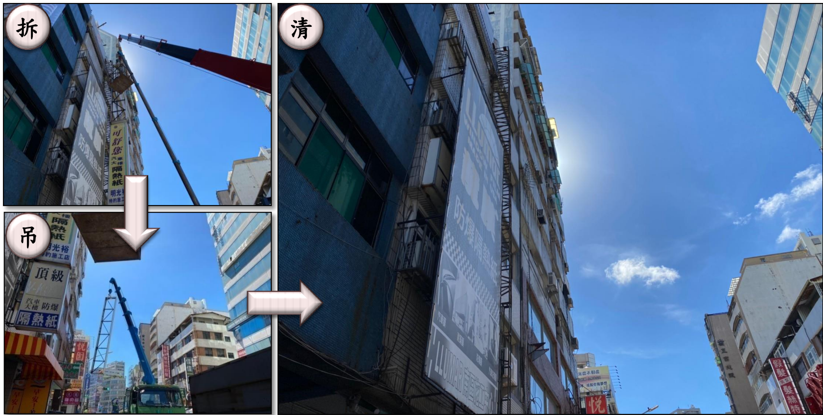
廣告招牌拆除
