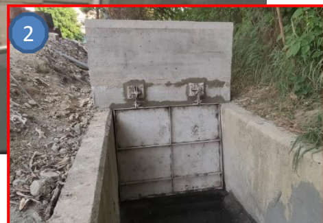
設置自動開門
