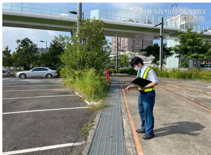
輕軌機廠排水設施清疏
