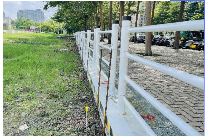
美術館型鋼式護欄以鋼筋綁固
