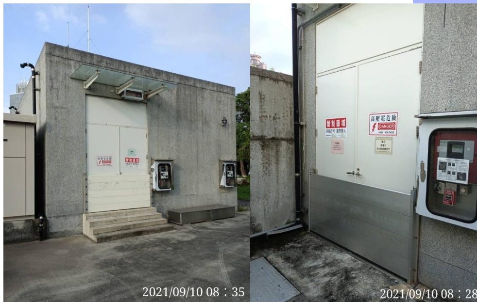
輕軌設備室防洪擋板架設
