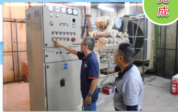
發電機運轉測試
