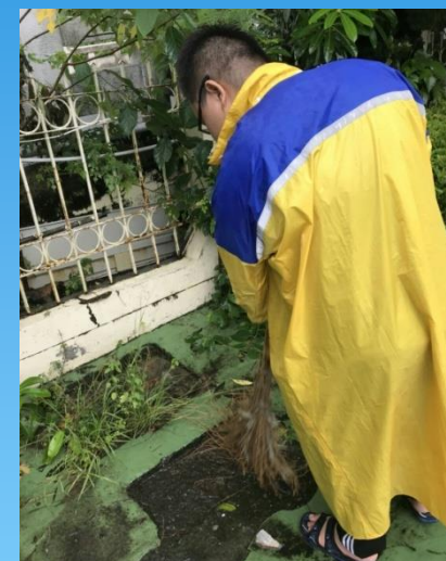
安置機構清掃排水溝
