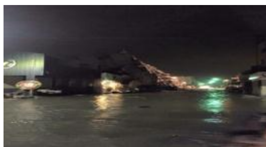
(c)維冠金龍大樓倒塌壓破管線 (永大路二段及國光五街口)
