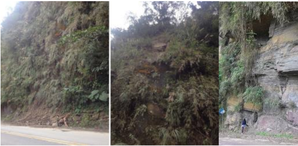
圖 4.2.17、草嶺 149 甲線 31.5K 之落石坍方(上圖為 Google 街景圖，下方照片由災防科技中心拍攝)
