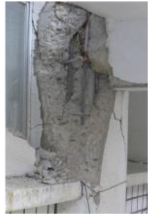
圖 3.2.12、南化區公所有大量柱體發生剪力破壞（國震中心提供）
