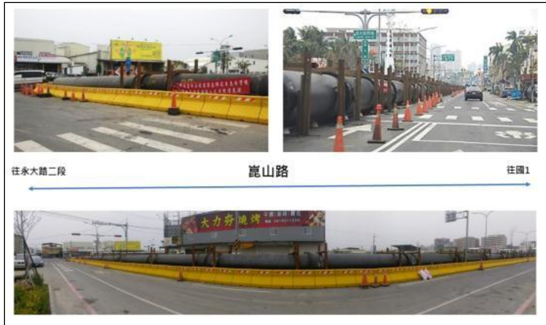
圖 2.3.3、明管鋪設情形(災防科技中心)
