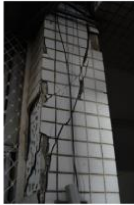
圖 3.2.10、歸仁國中光華樓柱結構性損壞（國震中心提供）
