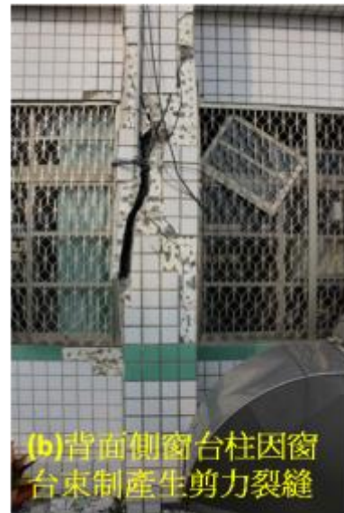
圖 3.2.1、玉井國中專科教室一樓窗台柱出現斜向剪力裂縫（國震中心提供）
