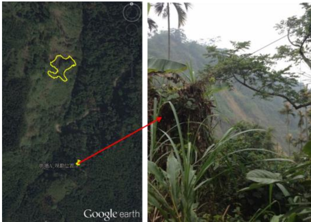
圖 4.2.12、中崙村內新增之崩塌 A(0.37 公頃)，左下標記點為現勘位置與右下照片（災防科技中心拍攝），黃線區域為水保局衛星影像判釋之結果。上圖左右分別為前期(2014)與後期(2016/2/8)之衛星影像。
