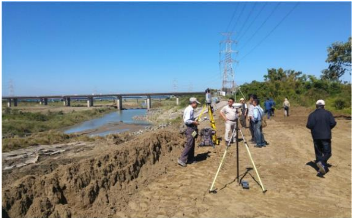
圖 3.2.17、日新堤岸側潰滑移破壞災情（國震中心提供）
