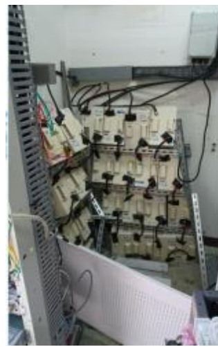
(b)電池主機位移 (遠傳電信)
