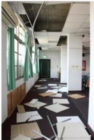
圖 3.2.2、玉井國中專科教室輕鋼架天花板掉落（國震中心提供）
