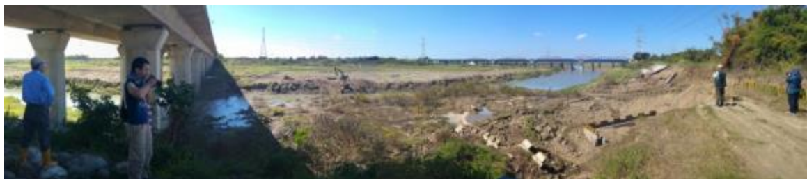
圖 3.2.18、南二高曾文溪橋堤岸側潰破壞情況（國震中心提供）
