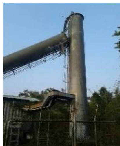
(d)鐵塔倒塌 (亞太電信)
