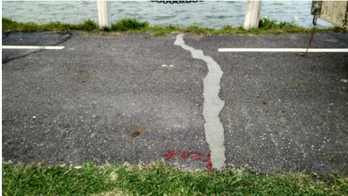
圖 2.8.2、虎頭埤水庫裂縫填補完成（資料來源：經濟部）
