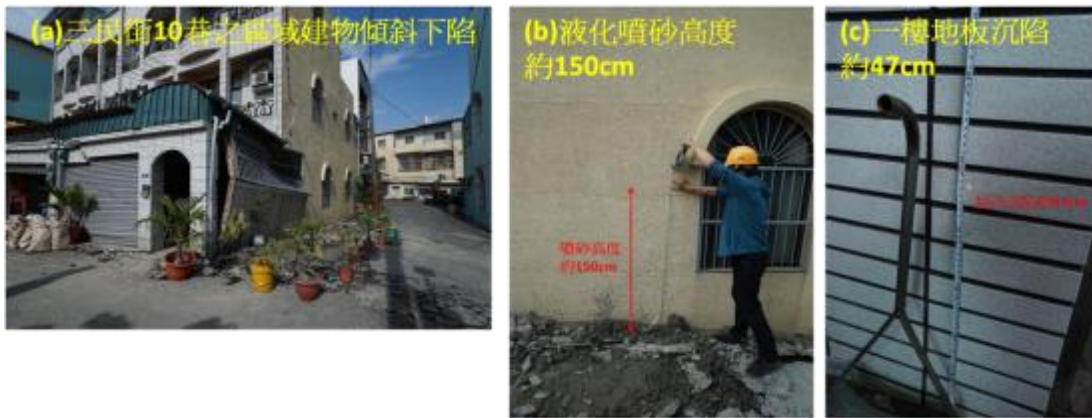
圖 3.2.15、臺南市新市區三民街 50 巷 10 弄液化引致建物傾斜下陷 (國震中心提供)
