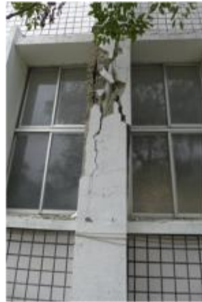
圖 3.2.12、南化區公所有大量柱體發生剪力破壞（國震中心提供）
