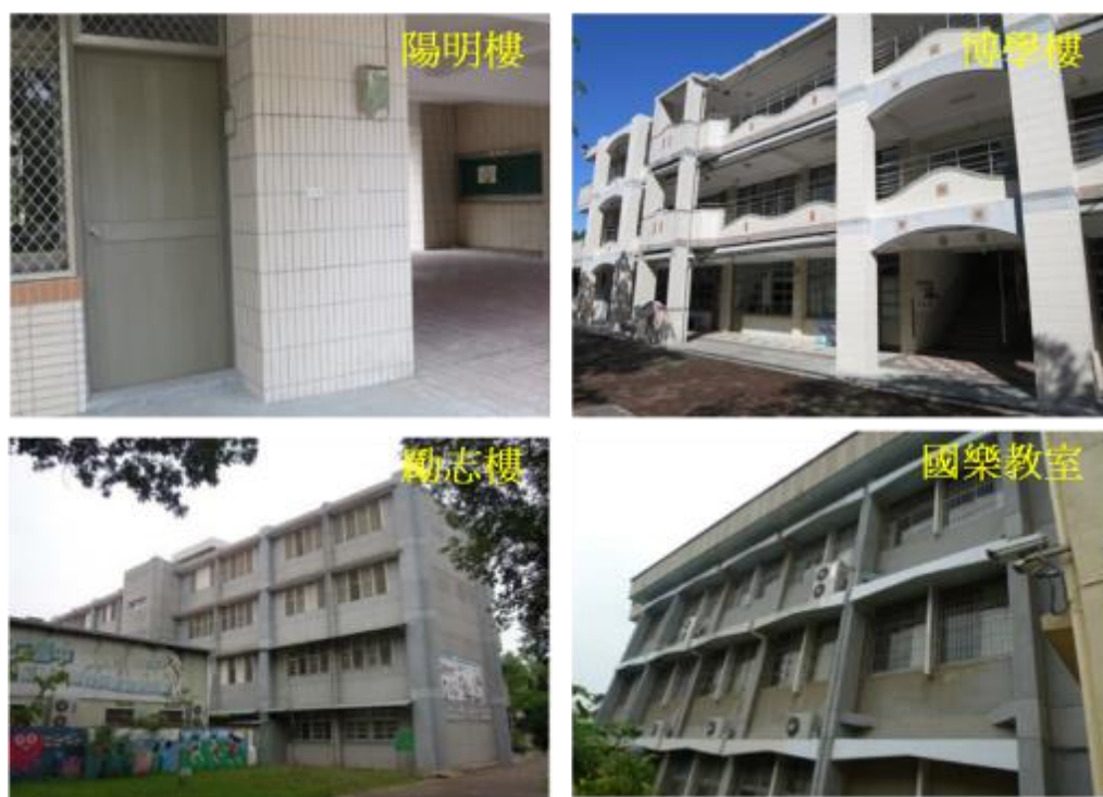
圖 3.2.9、歸仁國中已補強竣工校舍（陽明樓、博學樓、勵志樓及國樂教室）於本次地震無結構損壞（國震中心提供）
