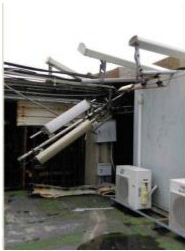
(a)附掛建物屋頂之基地台脫落 (遠傳電信)
