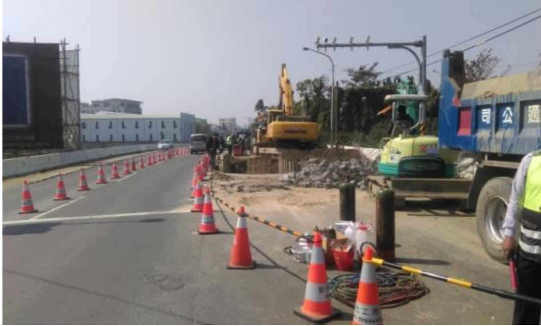
圖 2.7.2、台 20 線 012K+050~012K+150 自來水管爆裂進行搶修作業（資料來源：交通部）
