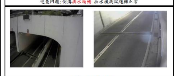
巡查地點:大寮地下道
