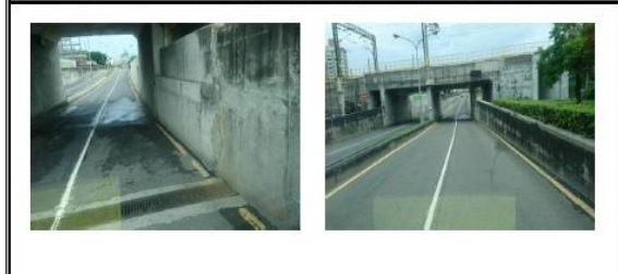
巡查地點:同置地下道
