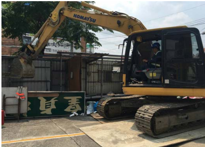
危險廣告招牌拆除情形
