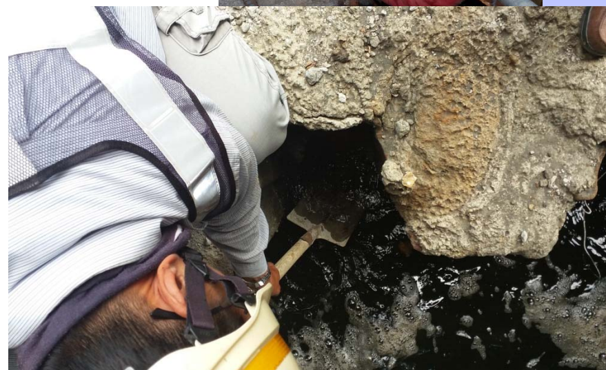
愛河高架橋進行清淤工作
