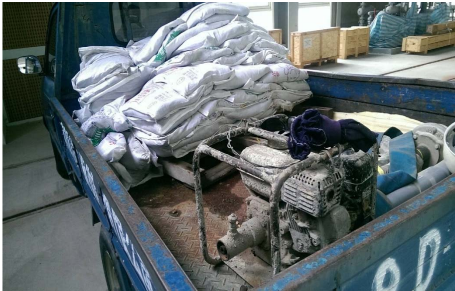
輕軌機廠增設抽水設備
