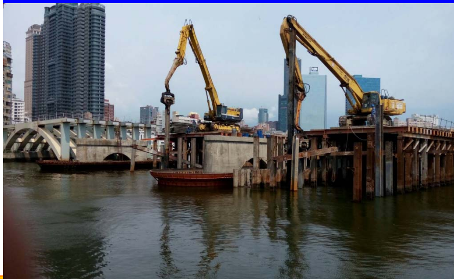
預留現場施工中兩部大型機具
