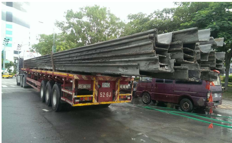
圍堰鋼板樁、構台及鋼柱立即清運離場
