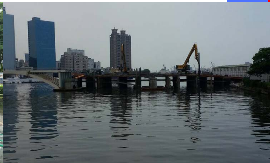
鋼板樁圍堰拔除後愛河水流順暢
