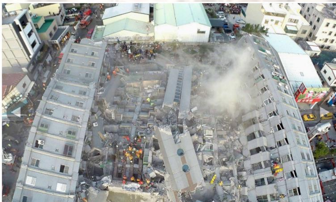
圖 3 台南維冠大樓倒塌
