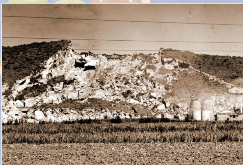
圖 2 民國 55 年 8 月 23 日半屏山再度崩塌景象
