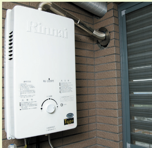
▲熱水器安裝在室外；若安裝在室內應加裝強制排氣裝置，並注意與戶外空氣流通
