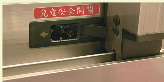
▲窗戶使用隱形鐵窗、防護裝置
