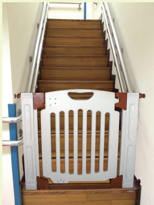
▲ 在樓梯設置防止進入柵欄
